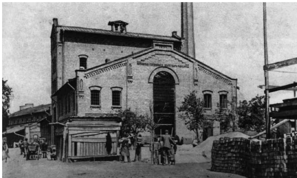
Główny gmach produkcyjny – aparatornia, kotłownia, hala odbieralników, przełom XIX i XX w.
