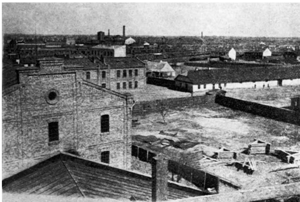
Widok z budynku aparatowni w kierunku ul. Białostockiej, przełom XIX i XX w.
