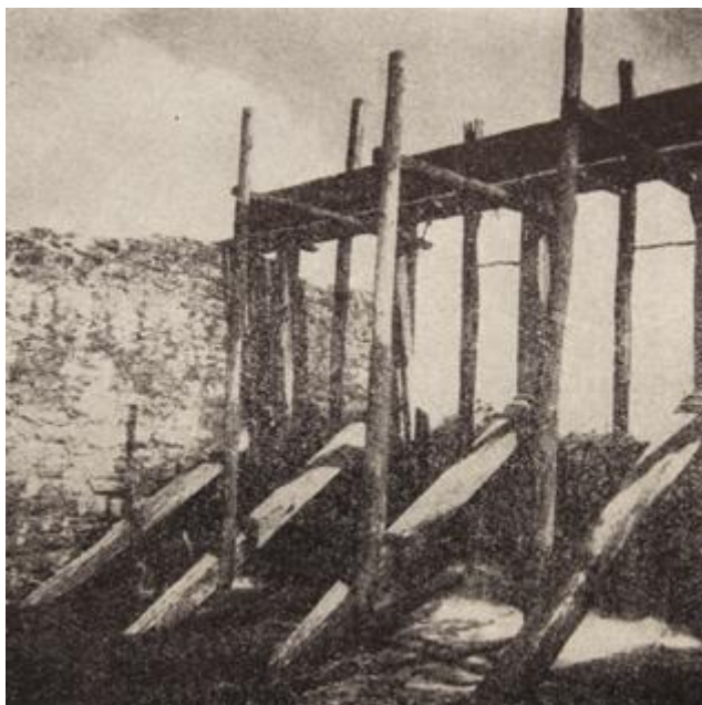
Fot. 2. Mroczków-Kapturów, młyn wodny zbożowy, upust jałowy (wg Katalog Zabytków Budownictwa Przemysłowego w Polsce , t. 2, Województwo kieleckie , red. J. Pazdur, z. 2, Powiat Kielce , opr. E. Krygier, Wrocław-Warszawa 1959)
