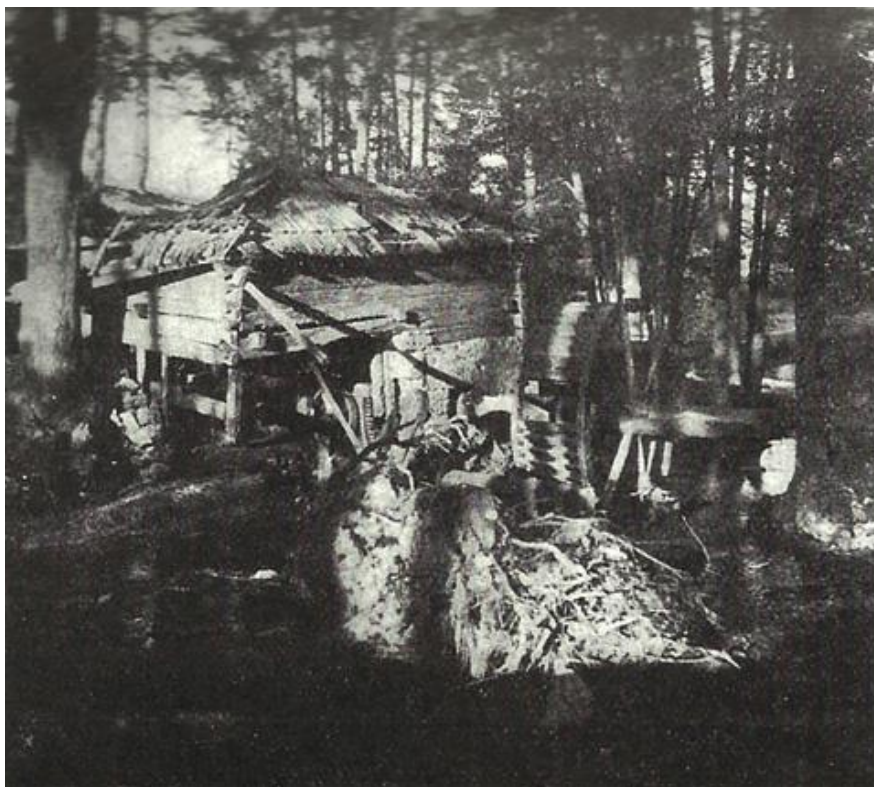
Fot. 2. Parszów, młyn wodny zbożowy (wg Katalog Zabytków Budownictwa Przemysłowego w Polsce, t. 2, Województwo kieleckie, red. J. Pazdur, z. 3, Powiat Iłża, miasto Skarżysko-Kamienna, miasto Starachowice – województwo kieleckie, opr. E. Krygier, Wrocław-Warszawa 1961)
