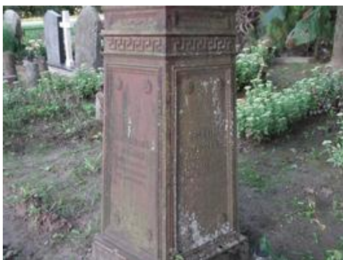
Fot. 6. Porosty i korozja na powierzchni pomnika
