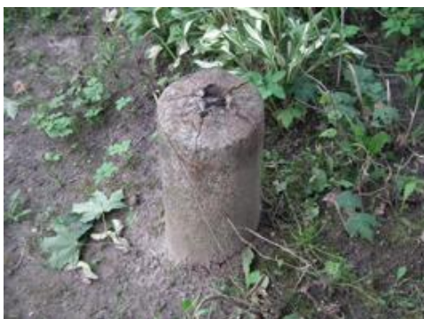
fot. 7. Granitowy słupek zniszczony w wyniku korozji żelaznego elementu.
