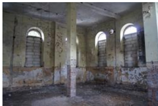
Mała Synagoga w trakcie prac budowlano-konserwatorskich
