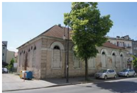
Mała Synagoga w trakcie prac budowlano-konserwatorskich
