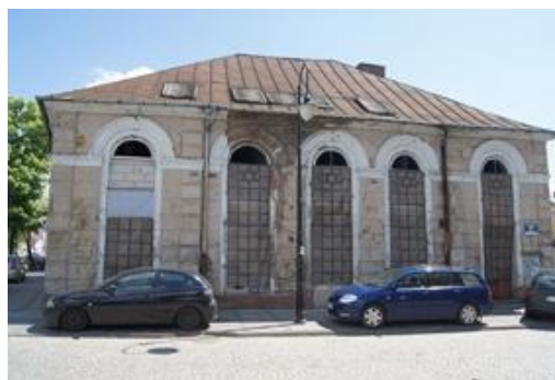
Mała Synagoga w trakcie prac budowlano-konserwatorskich
