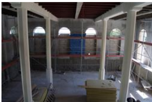
Mała Synagoga w trakcie prac budowlano-konserwatorskich
