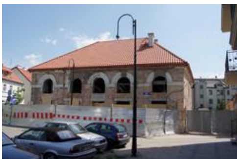
Mała Synagoga w trakcie prac budowlano-konserwatorskich
