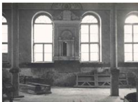
Mała Synagoga w trakcie prac budowlano-konserwatorskich
