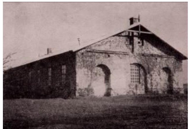
Rys.4. Bobrza. Hala fabryczna
