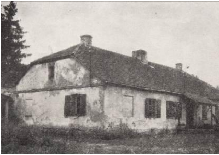
Rys.5. Bobrza. Dom mieszkalny w osiedlu fabrycznym
