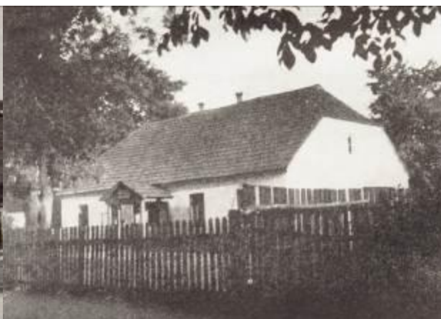
Rys.4. Białogon. Dom mieszkalny w osiedlu
