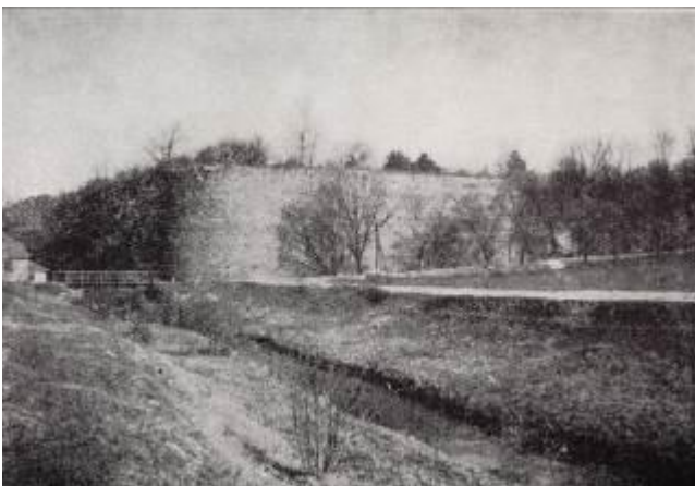
Rys.3. Bobrza. Mur oporowy od strony
