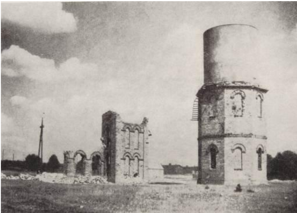
Rys.9. Bliżyn. Ruiny stalowni
