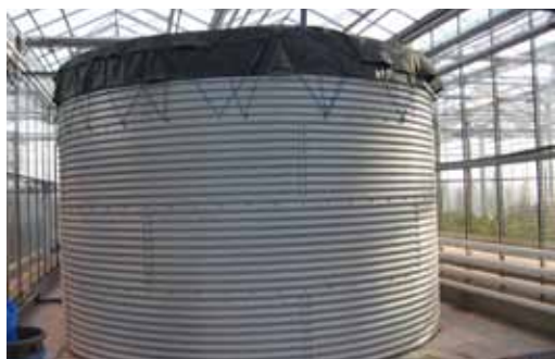
12. Zbiornik na wodę deszczową
