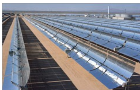
Zdjęcie nr 1. Kolektory skupiające 2
