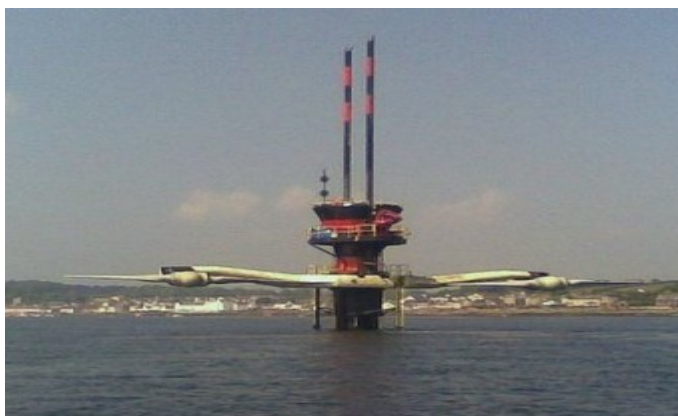
Zdjęcie nr 6. Generator pływowy z wirnikiem wysuniętym nad powierzchnię wody. 17
