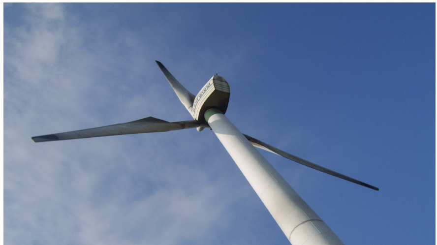
Fot. Beata Rusin „Turbina wiatrowa w miejscowości Wysokie”(gmina Kramsk)
