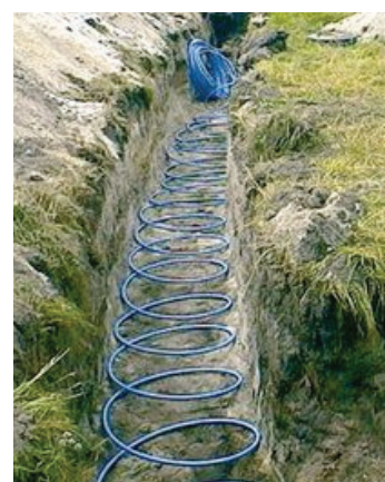
Rys. 143. Sposób układania kolektora gruntowego spiralnego
