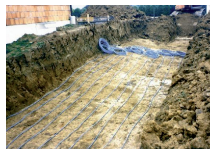
Rys. 141. Sposób układania kolektora gruntowego płaskiego
