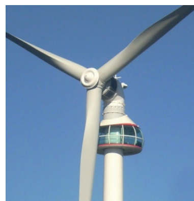
Rys. 110. Wiatrak firmy Leitwind z platformą widokową
