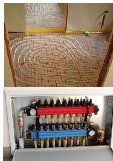
Rys. 146. Instalacja ogrzewania podłogowego
