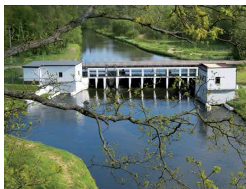
Rys. 149. Elektrownia wodna Łebień
