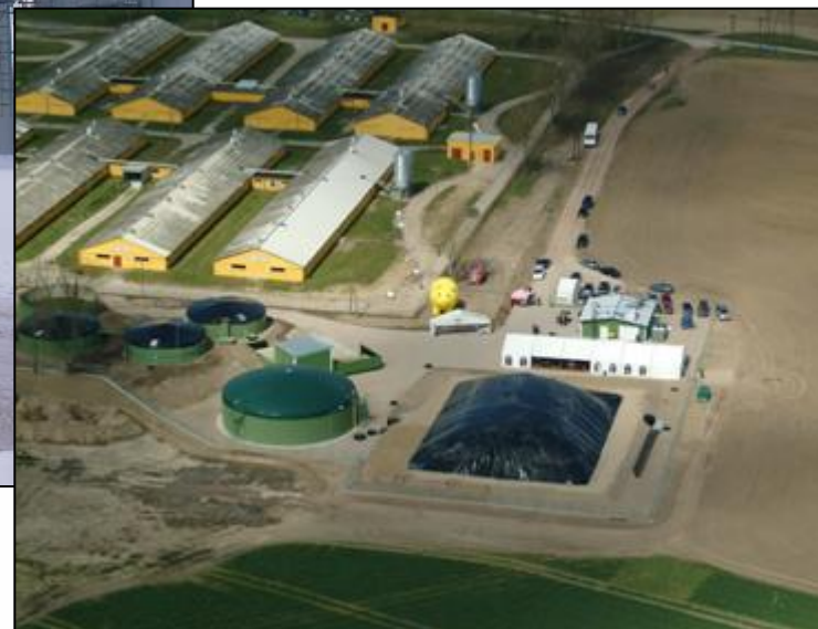
Biogazownia w Płaszczycy Poldanor S.A.
