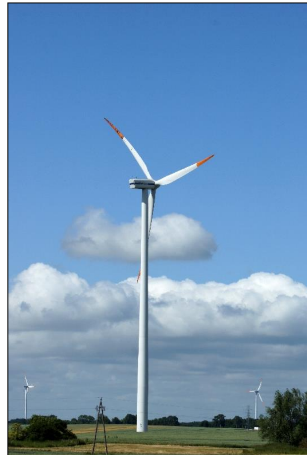
Farma wiatrowa w Tymieniu koło Kołobrzegu 25 wiatraków o łącznej mocy 50 MW, turbiny: Vestas V80 o mocy 2,0 MW każda
