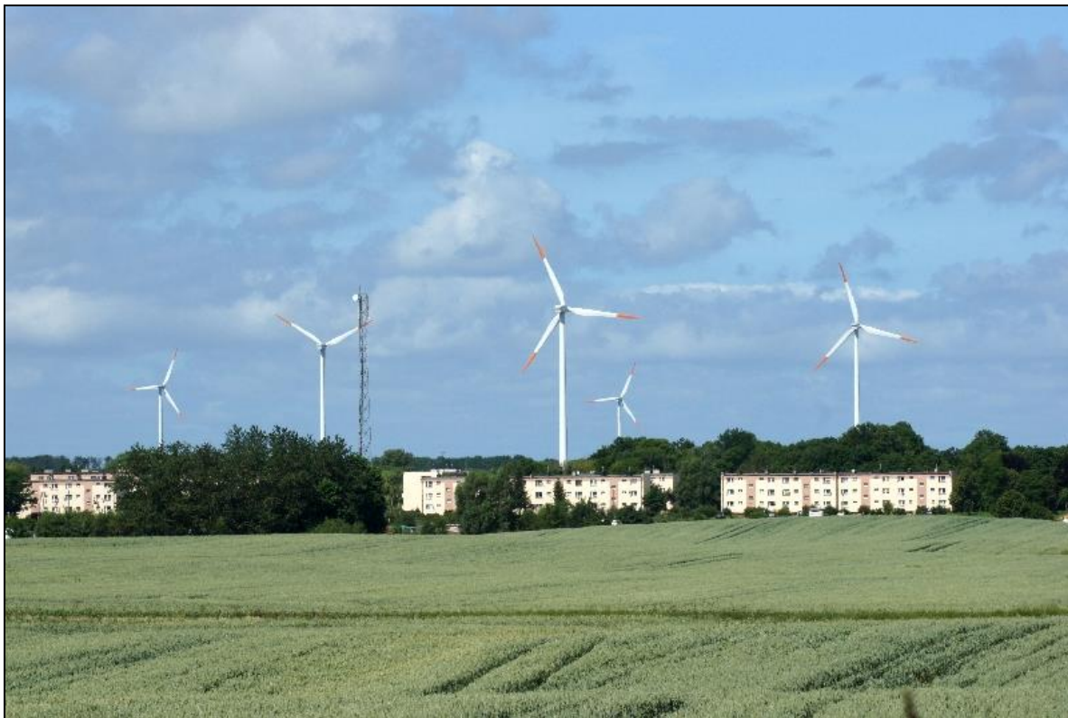
Farma wiatrowa w Tymieniu koło Kołobrzegu 25 wiatraków o łącznej mocy 50 MW, turbiny: Vestas V80 o mocy 2,0 MW każda
