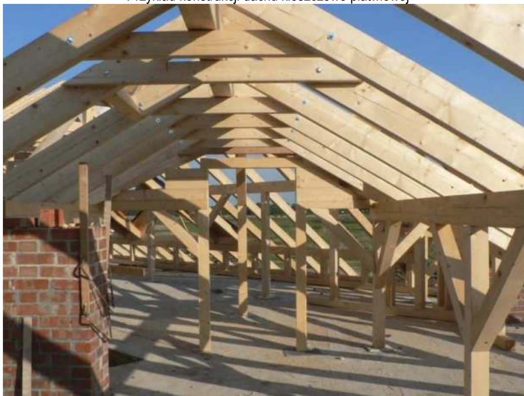
Przykład konstrukcji dachu kleszczowo płatwiowej
