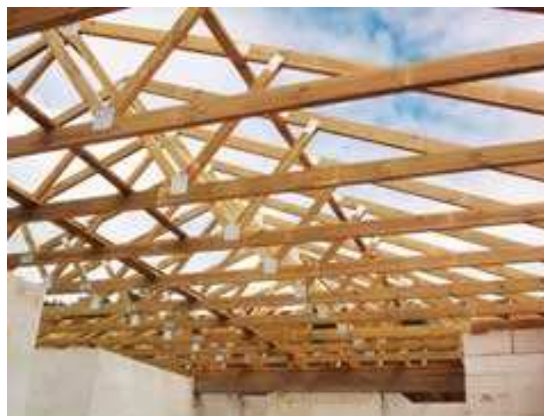
Przykład konstrukcji z więzarami kratowymi
