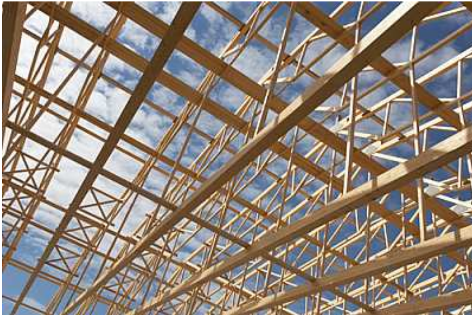
Przykład skomplikowanej konstrukcji z wiązarami kratowymi
