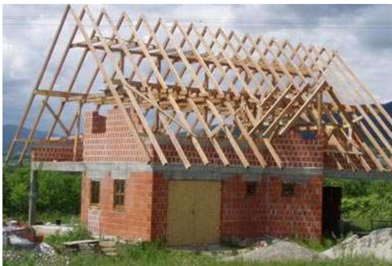
Przykład konstrukcji dachu kleszczowo płatwiowej
