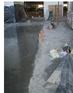
Rys.6.18. Ręczna maszyna do zacierania z łopatkami zacierającymi i widoczny szklisty połysk po zatarciu posypki utwardzającej. Źródło własne
