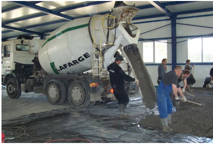
Rys. 6.13. Rozścielanie mieszanki betonowej. Rys. 6.14. Wyrównywanie powierzchni i jej odpowietrzanie.
