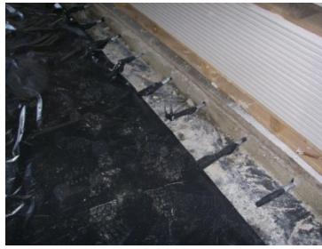
Rys.6.7. Dyble umieszczone na krawędzi pasa roboczego. Źródło własne
