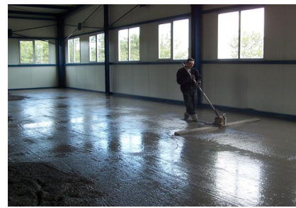
Rys. 6.13. Rozścielanie mieszanki betonowej. Rys. 6.14. Wyrównywanie powierzchni i jej odpowietrzanie.
