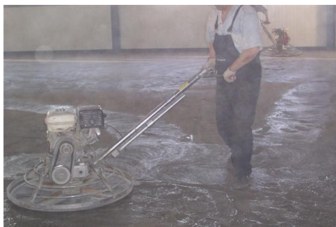
Rys.6.18. Ręczna maszyna do zacierania z łopatkami zacierającymi i widoczny szklisty połysk po zatarciu posypki utwardzającej. Źródło własne
