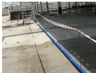
Rys.6.3. Ulokowanie przewodów przed ułożeniem płyty konstrukcyjnej. Źródło własne
