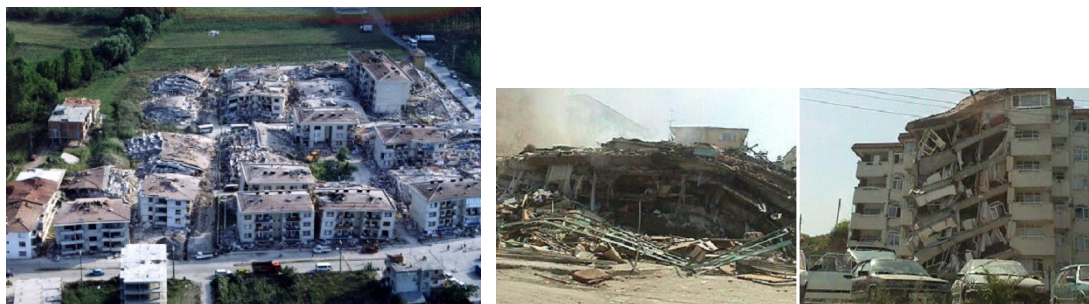
Fot. 1. Zniszczenia budynków po trzęsieniach ziemi
