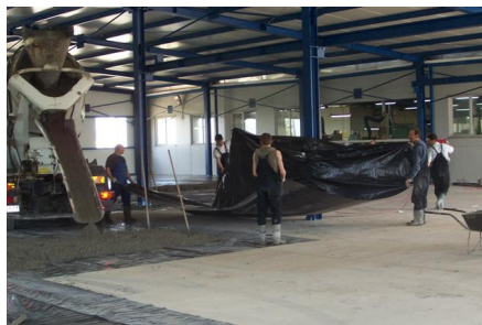
Rys.6.6. Układanie folii PE na podkładzie betonowym. Źródło własne
