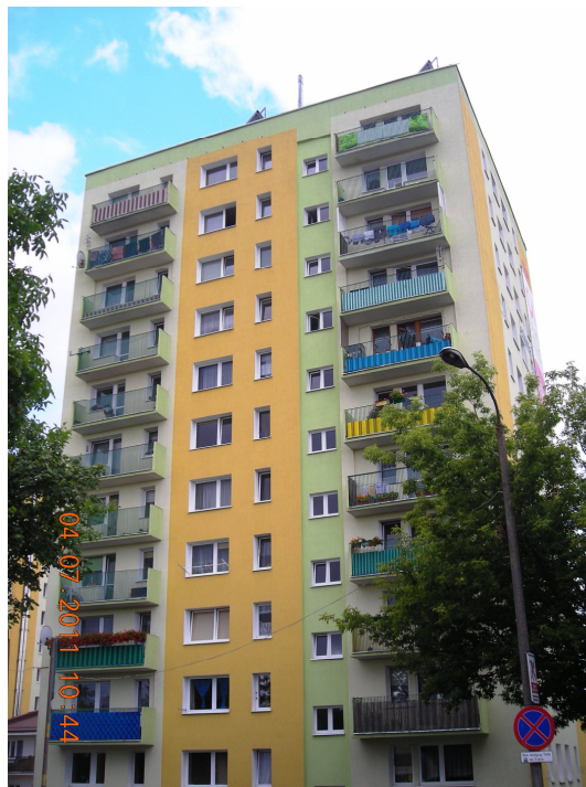
Zdj. 12. budynek Olsztyn ul. Jeziorna1 wykonany w deskowaniu ślizgowym [własny]
