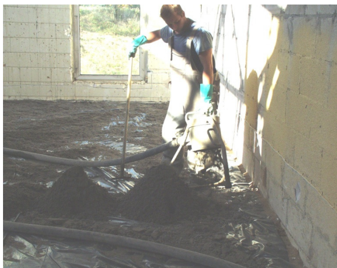
Zdj. 14. układanie jastrychu (kruszywo jednofrakcyjne+cement+woda konsystencja betonu wilgotna) [fot.własna]
