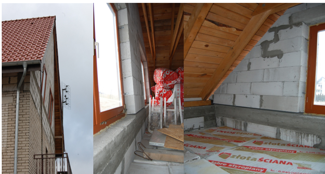
Zdj. 36. Przykład „wysiania” przez wiatr ściany szczytowej [własne]
