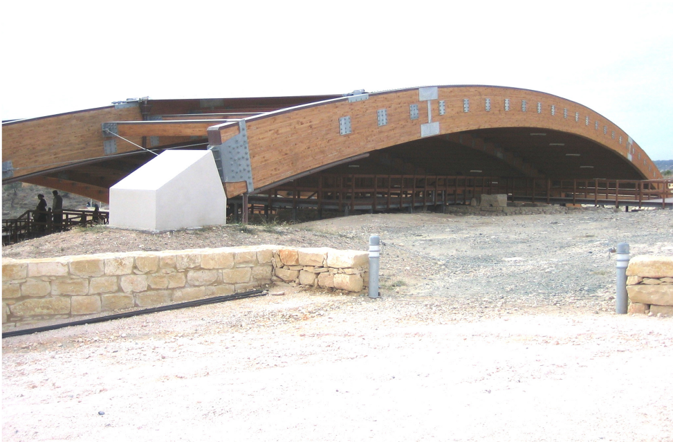
Zdj. 24. Przykład dźwigarów klejonych
