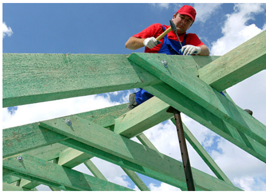
Zdj. 16. Montaż więźby dachowej płatwiowo-kleszczowej; widać kleszcze obejmujące krokwie i zacięte krokwie opierające się na płatwi pośredniej [1]
