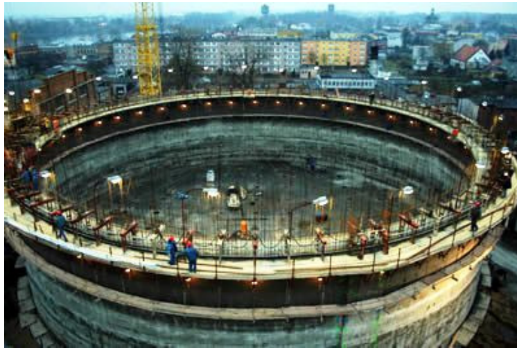
Zdj. 11. deskowanie ślizgowe betonowania płaszcza komina żelbetowego [1]
