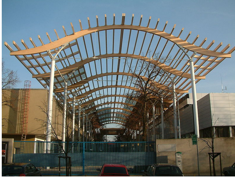
Zdj. 23. Przykład dachu o różnej konstrukcji
