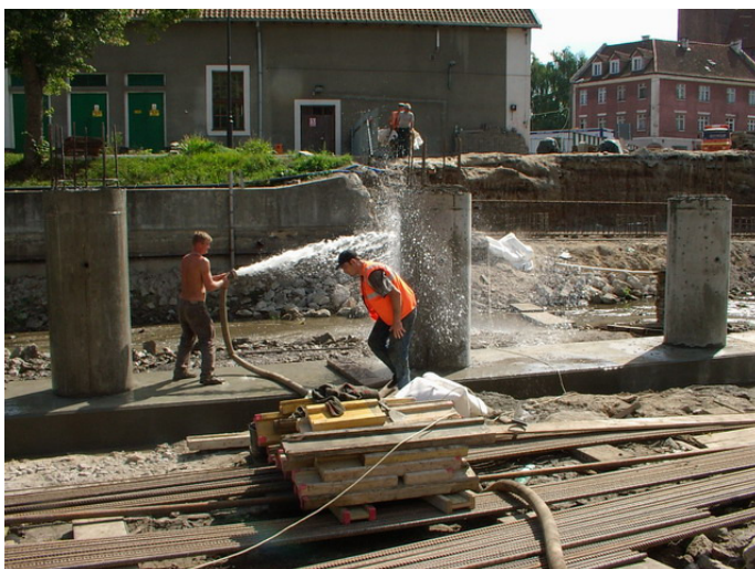
Zdj. 3. pielęgnacja betonu
