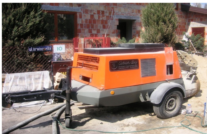
Zdj. 13. Pompa do betonu (miksokret)[1]
