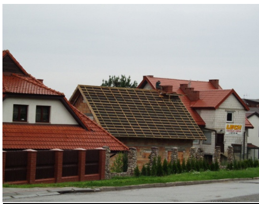
Zdj. 17. Montaż kontrłat i łat konstrukcja pod dachówkę [własna]
