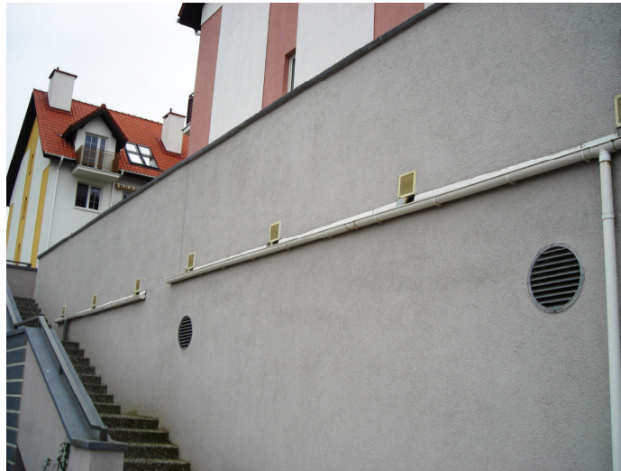
Zdj. 32. Odwodnienie zielonego dachu na Osiedlu Generałów w Olsztynie (fot. własna)
