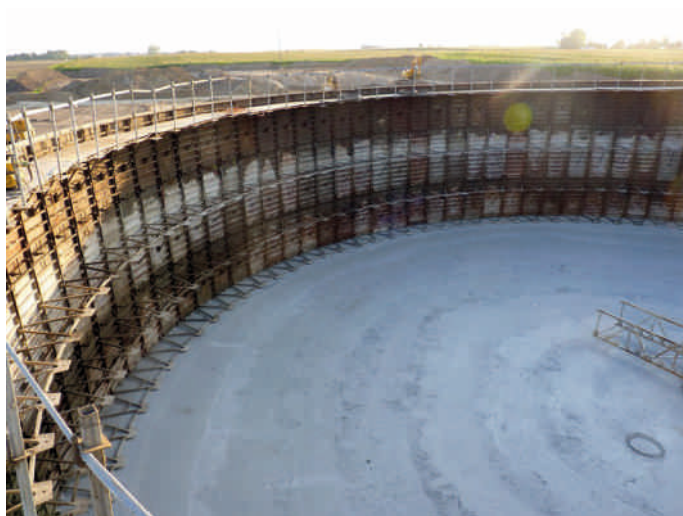
Deskowanie ścian zbiornika
