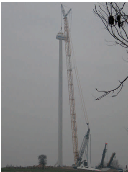
Montaż gondoli na wieży
