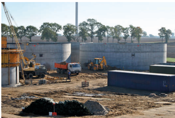
Żelbetowe zbiorniki fermentacyjne po rozdeskowaniu
