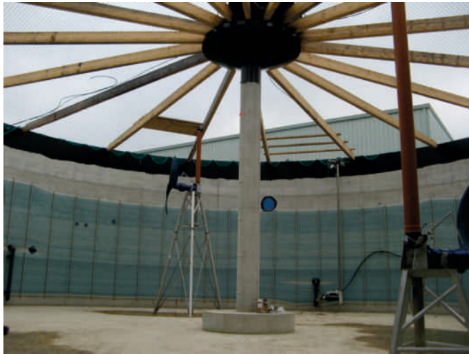
Konstrukcja dachu zbiornika fermentacyjnego (fot. Tadeusz Domasiewicz)
