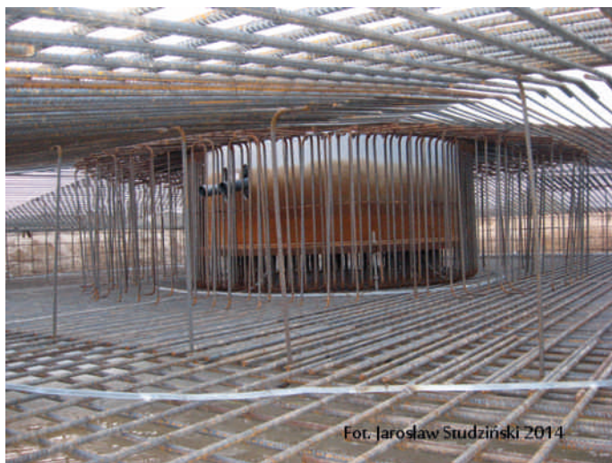
Wnętrze szkieletu zbrojonego stopy fundamentowej
