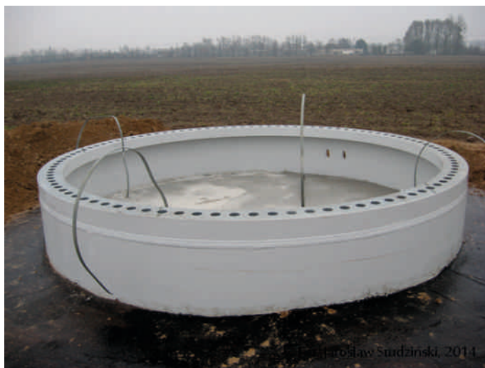
Segment fundamentowy po zabetonowaniu, przygotowany do montażu elementów wieży
