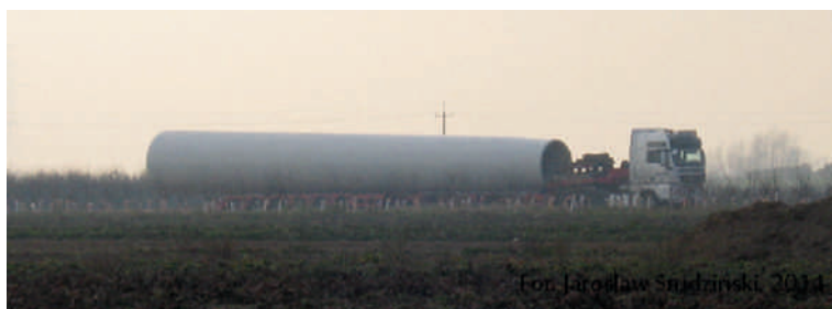
Transport elementów wieży na miejsce montażu
