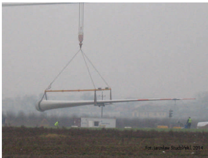
Transport trzeciej łopaty wirnika na miejsce montażu
