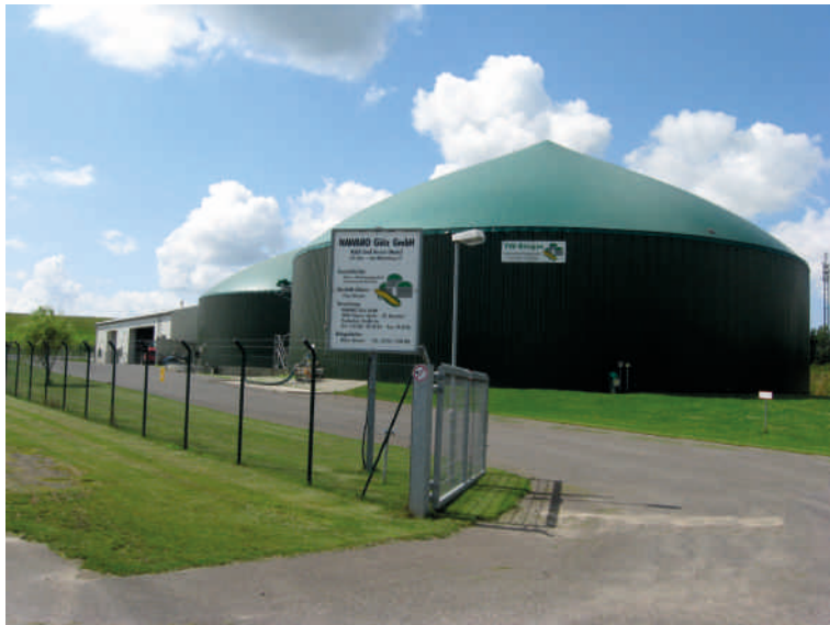
Biogazownia w Götzt, Niemcy
