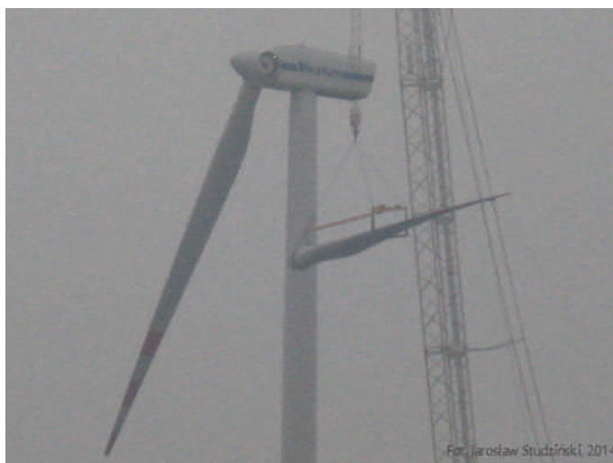
Montaż drugiej łopaty rotora
