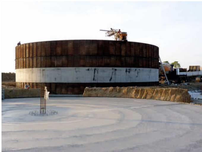
Na pierwszym planie płyta dna zbiornika fermentacyjnego, na drugim – żelbetowy płaszcz zbiornika, częściowo rozdeskowany
