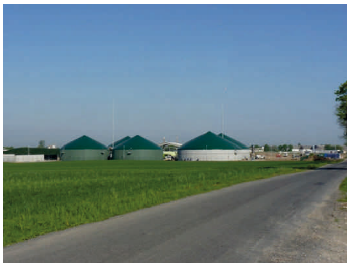
Biogazownia Rypin (fot. Janusz Cieszyński)
