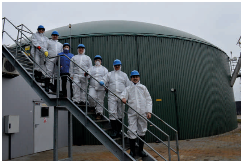
Uczestnicy grupy 29 pod zespołem zbiorników – biogazowni w miejscowości Rypin
