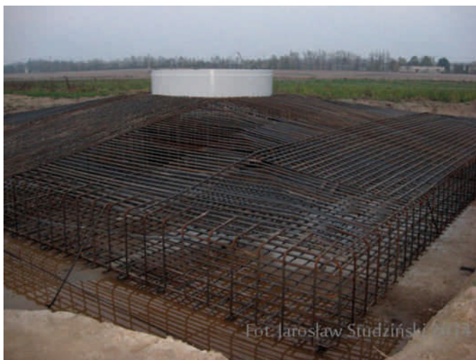
Zbrojenie stopy fundamentowej pod wieżę elektrowni wiatrowej (wiatraka)
