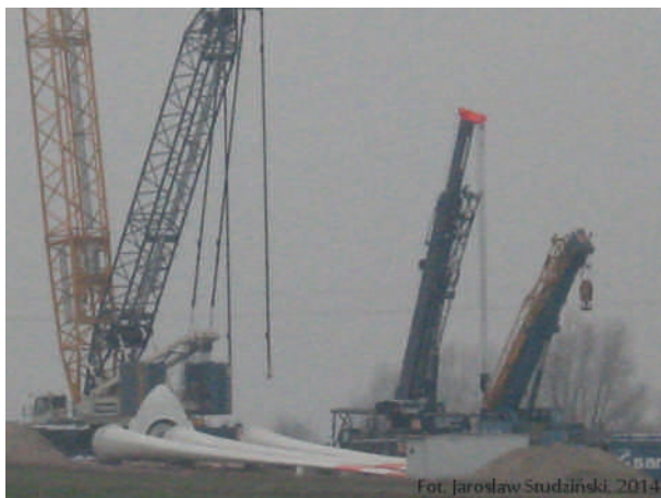
Przygotowanie żurawia do montażu elementów elektrowni wiatrowej
