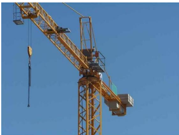
Rysunek 13.1 Dźwig budowlany
