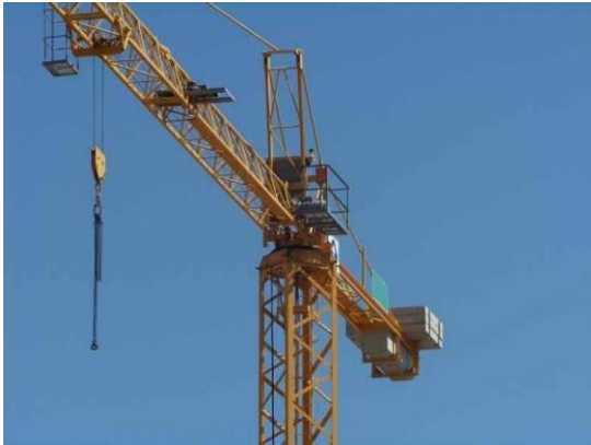
Rysunek 12.1 Dźwig budowlany
