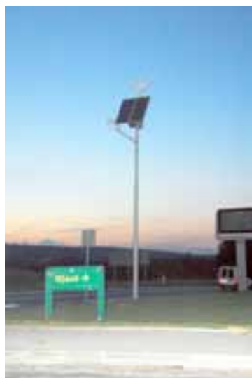
System wykorzystujący energię słoneczną i wiatrową do oświetlania przejść dla pieszych w miejscach, gdzie nie ma sieci elektrycznej.
