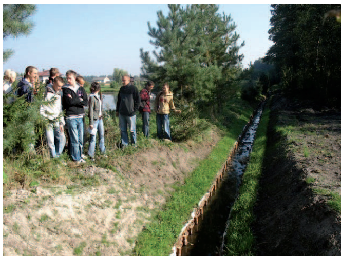
Uczniowie kształcący się w zawodzie technik inżynierii środowiska przy wykonanym obiekcie w ramach zajęć praktycznych
