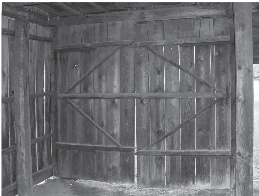
14. Lublin, MWL. Wyzyna Lubelska, Żabno. Zewnętrzna i wewnętrzna strona drzwi deskowo-listwowo zastrzałowych, prowadzących na podwórze okólnika gospodarczego, koniec XIX w. Fot. A. Cichy
