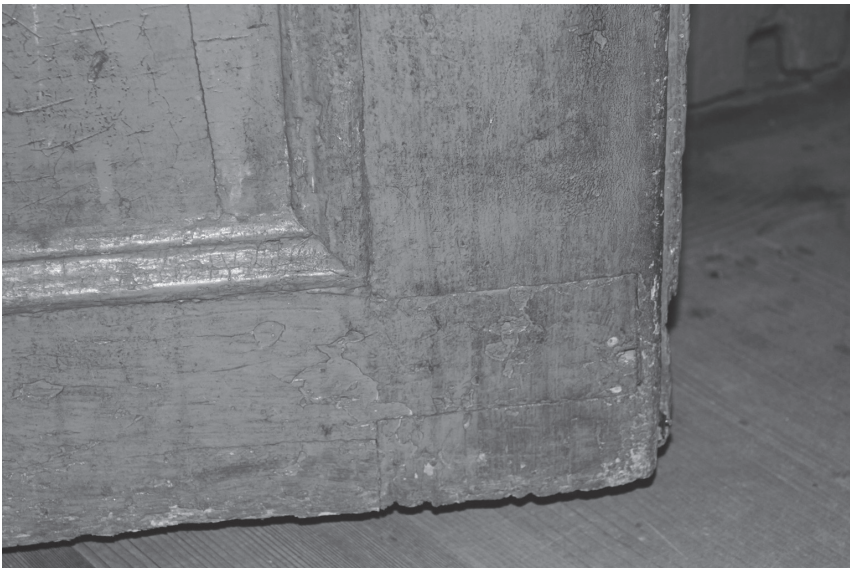
27. Książnica Śląska. Dwór, XVIII i XIX w. Drzwi ramowo-płycinowe prowadzące na poddasze i szczegół połączenia narożnego ramiaków na złącze czopowe płetwowe (o przekroju trapezu) nieprzelotowe odkryte. Fot. A. Cichy
