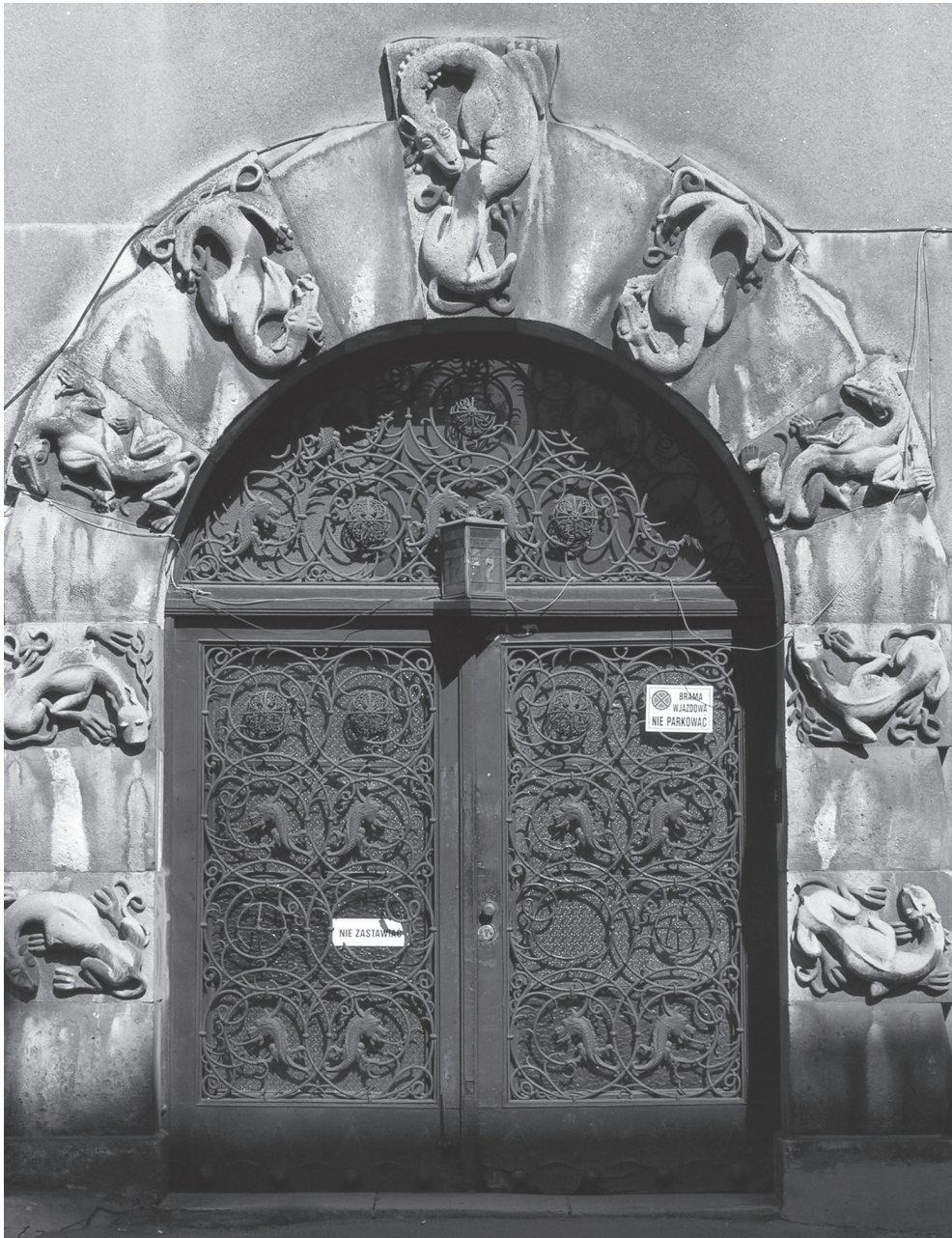
77. Kraków, ul. Juliusza Lea 17. Drzwi szklone okładane blachą z dekoracyjną kratą, koniec lat 20. XX w. Fot. A. Cichy
