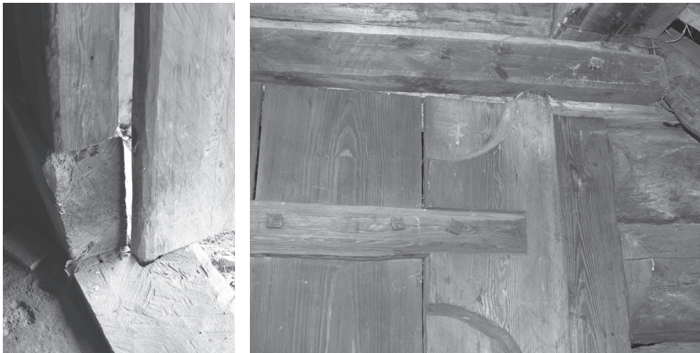
5. Lublin, MWL. Stodoła z Bukowej, 1839 i 1857 r. Widok drzwi biegunowych z dekoracyjnie opracowanym biegunem i szczegóły połączeń czopów z elementami konstrukcyjnymi ściany. Fot. A. Cichy
