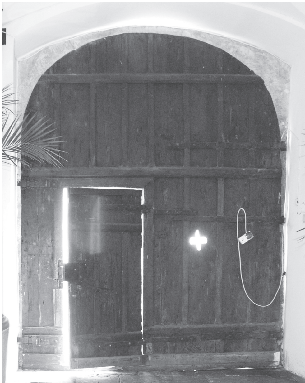
19. Kraków, ul. Kanonicza 7. Drzwi deskowo-szpungowe bez odrzwi z pionowymi listwami maskującymi styki desek. Fot. A. Cichy
