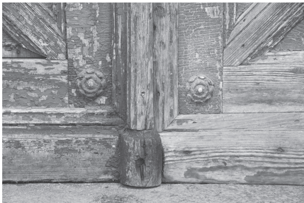
70. Toruń, ul. Mostowa 8. Drzwi ramowo-płycinowe szklone z elementami dekoracyjnymi wykonanymi z białego metalu, 2. poł. XIX w. Fot. A. Cichy
