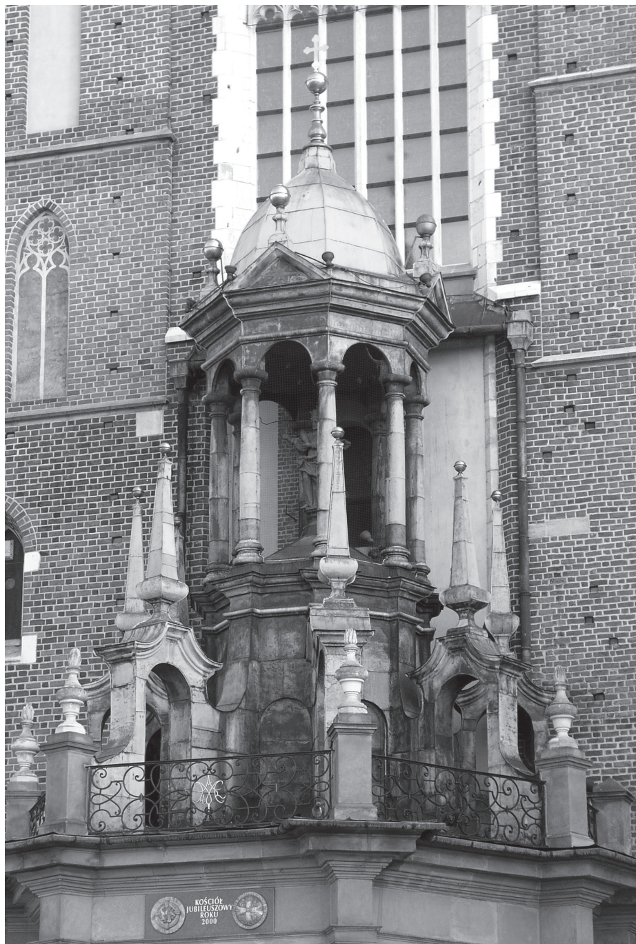
18. Patyna na dachu kościoła NMP w Krakowie. Fot. S. Safarzyński
