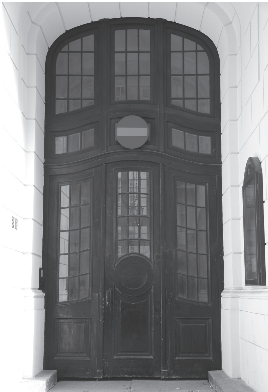
35. Warszawa, ul. Bagatela 10. Wrota zewnętrzne ramowo-płycinowe szklone w obrębie przejazdu bramnego i zarazem wejście do tzw. kamienicy Wildera (1911-1912), w której urodził się i mieszkał Krzysztof Kamil Baczyński. Proj. J. N. Czerwiński i W. Heppen. Fot. A. Cichy
