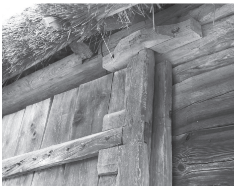
7. Lublin, MWL. Roztocze, Huta Dzierżyńska. Drzwi biegunowe, pierwsza połowa XIX w. Widok drzwi do stodoły i szczegóły połączeń czopów deski biegunowej z jarzmem i panewką przypominającego zasadą działania łożysko ślizgowe wzdłużne. Fot. A. Cichy
