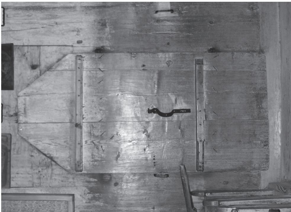
13. Dębno. Kościół parafialny św. Michała Archanioła. Drzwi desko- wo-listwowe wejścia zachodniego i południowego. Skromna deko- racja - wewnętrzna strona drzwi sciana kolorystycznie ze ścianą, awers ozdabiają i wzmacniają zawiasy. Fot. A. Cichy
