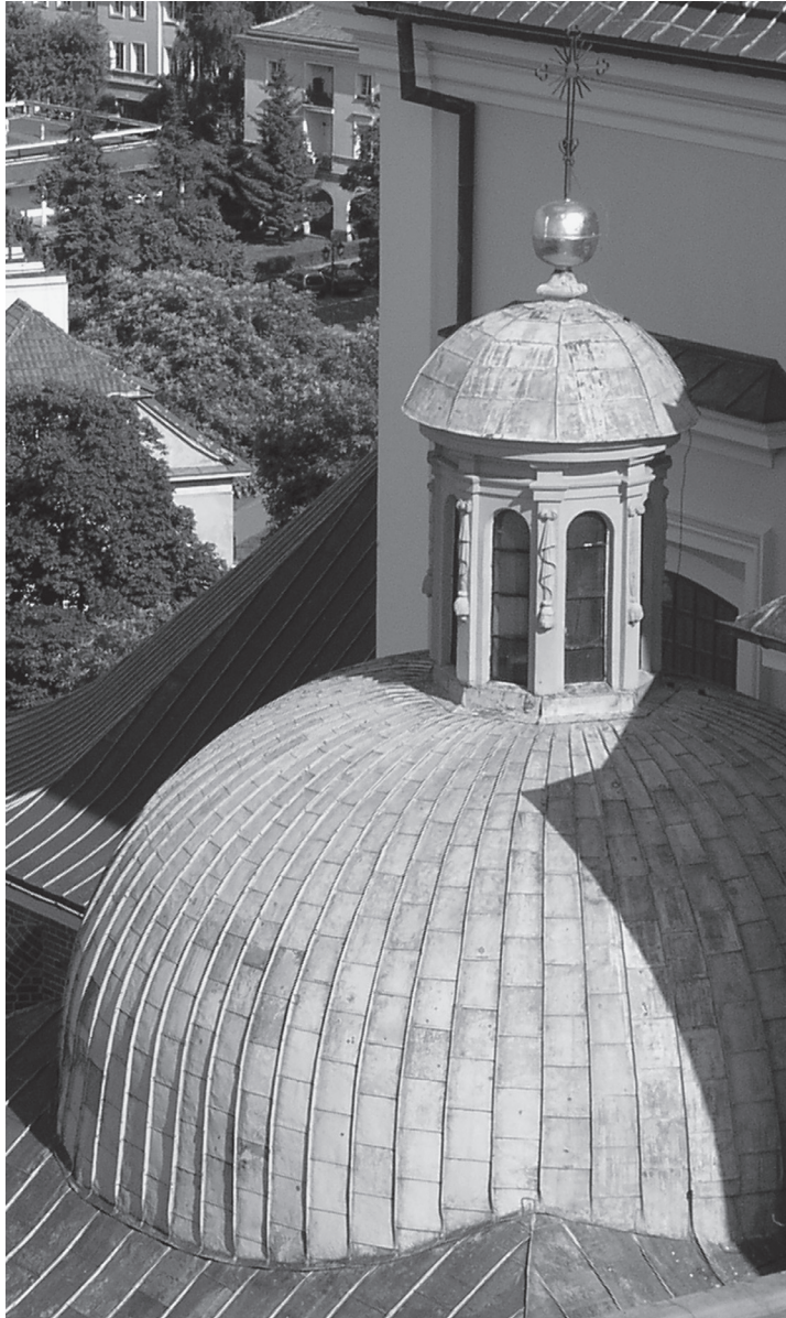
17. Warstewki o odcieniu zielonym wytworzone na miedzi i jej stopach tradycyjnie nazywane są powłokami patynowymi (patyną). W warunkach naturalnych, w atmosferze dość czystej, pozbawionej zanieczyszczeń gazami przemysłowymi, warstewka wytworzona na elementach architektonicznych (na przykład na miedzianych dachach) i obiektach wolno stojących (monumentach, pomnikach, posągach, rzeźbach itp.) składa się przede wszystkim z malachitu, tj. zasadowego węglanu miedzi(II); w atmosferze przemysłowo-miejskiej – głównie z zasadowego siarczanu(VI) miedzi(II). Patyna na dachu kościoła św. Anny w Warszawie. Fot. S. Safarzyński
