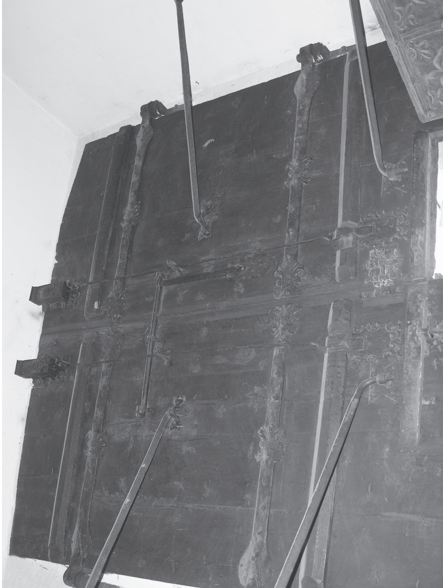
18. Kraków. Kościół misjonarzy p.w. Nawrócenia św. Pawła. Widok strony wewnętrznej skrzydeł drzwiowych o konstrukcji de- skowo-szpungowej bez odrzwi wzmocnionych dekoracyjnymi okuciami, 2. ćw. XVIII w. Fot. A. Cichy
