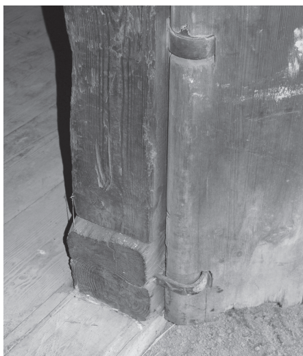
8. Lublin, MWL. Roztocze, Teodorówka. Drzwi biegunowe, przełom XIX i XX w. Awers drzwi i widok połączenia dolnego czopa deski biegunowej z panewką. Skrzydło jest zabezpieczone przed wypadnięciem czopa z panewki za pomocą metalowej obejmy osadzonej w podwalinie i przechodzącej przez otwór w desce. Fot. A. Cichy
