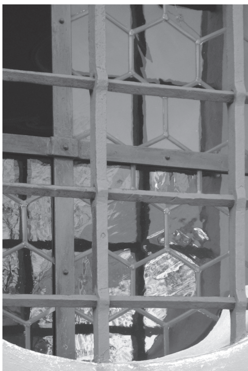
3. Szklenie w sześciokątne gomółki. Niemcy, XVIII w. Fot. M. Czeski
