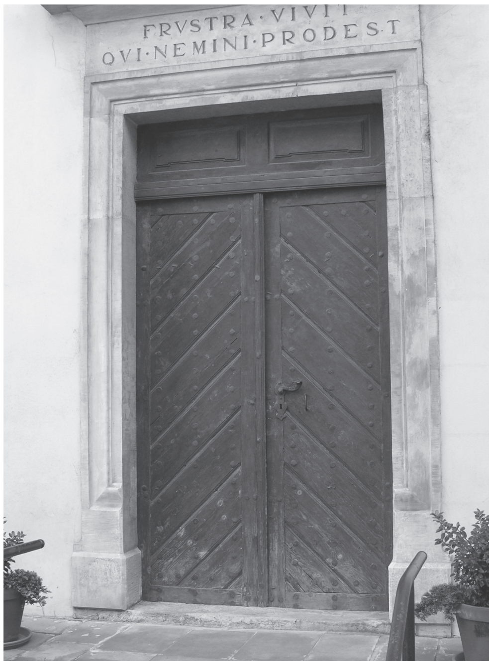
56. Kraków, Grodzka 58. Kościół ewangelicko-augsburski p.w. św. Marcina, 1637-40 r. Opierzenie drzwi deskowo-szpungowych w jodełkę odwróconą, o dużej szerokości desek, ujęte ramą. Fot. A. Cichy
