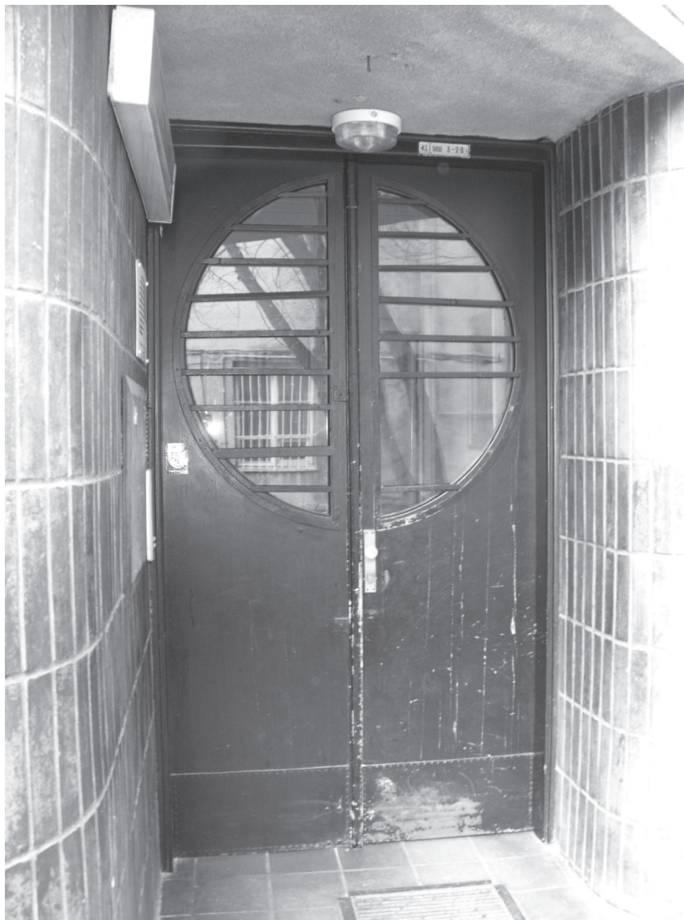
38. Warszawa, ul. Jaworzyńska 4. Dom mieszkalny, koniec I. 30. XX w. Drzwi płytowe, w których wewnętrzna rama wraz z wypełnieniem licowana jest drewnianymi deseczkami. Fot. A. Cichy
