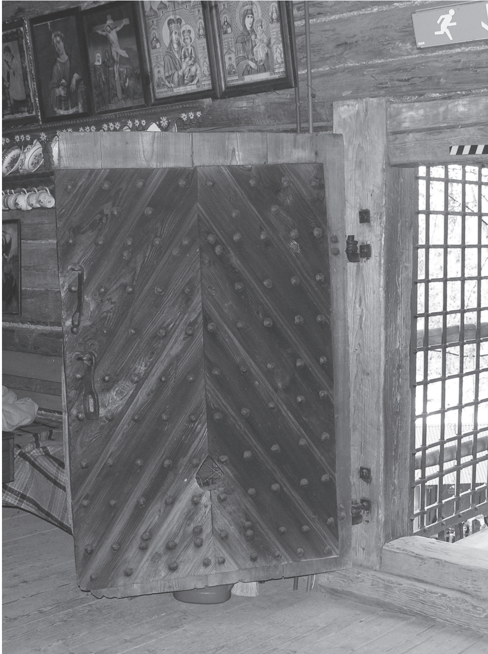
53. Niedzica. Spichlerz, koniec XVIII w. Drzwi deskowo listwowe z opierzeniem profilowanymi szalówkami w jodełkę odwróconą. Fot. A. Cichy
