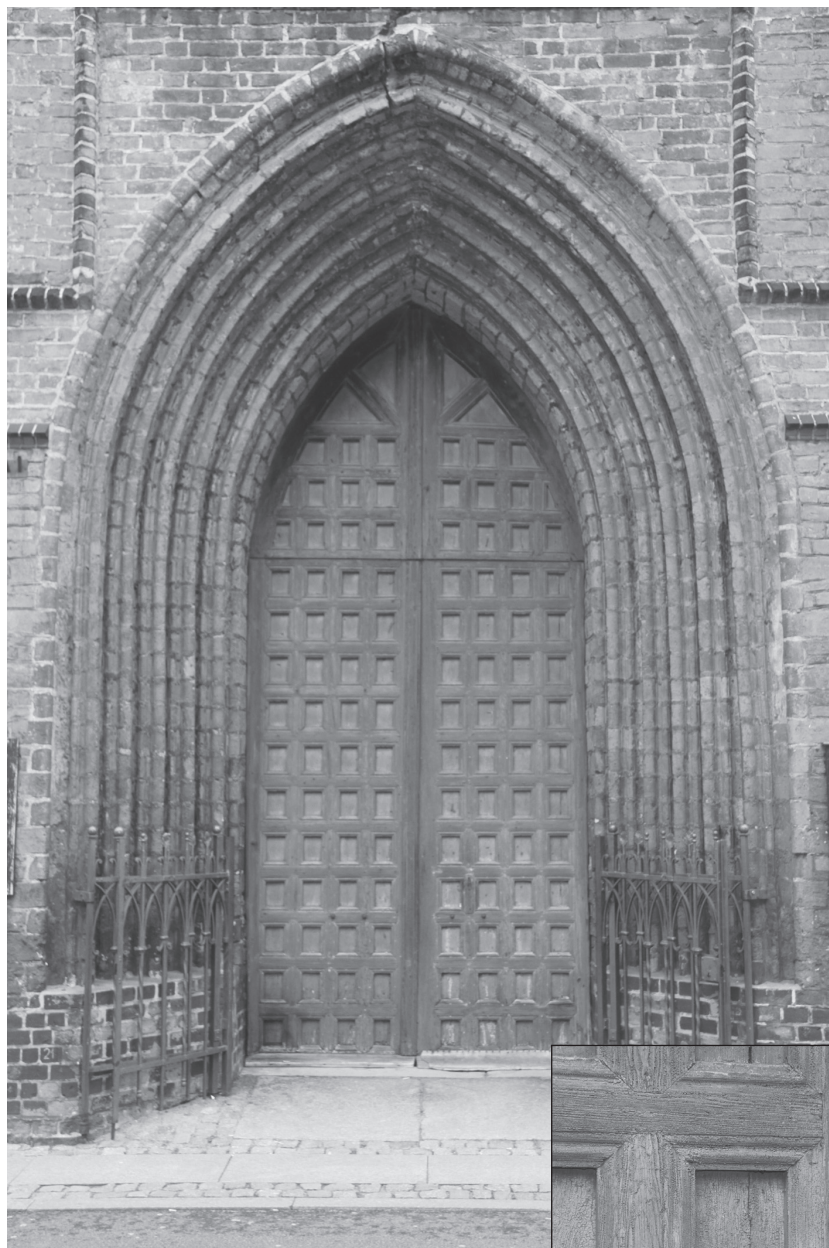
47. Toruń. Kościół Wniebowzięcia NMP. Drzwi z drewnianymi kratownicami, elewacja zachodnia, XV w. Fot. A. Cichy
