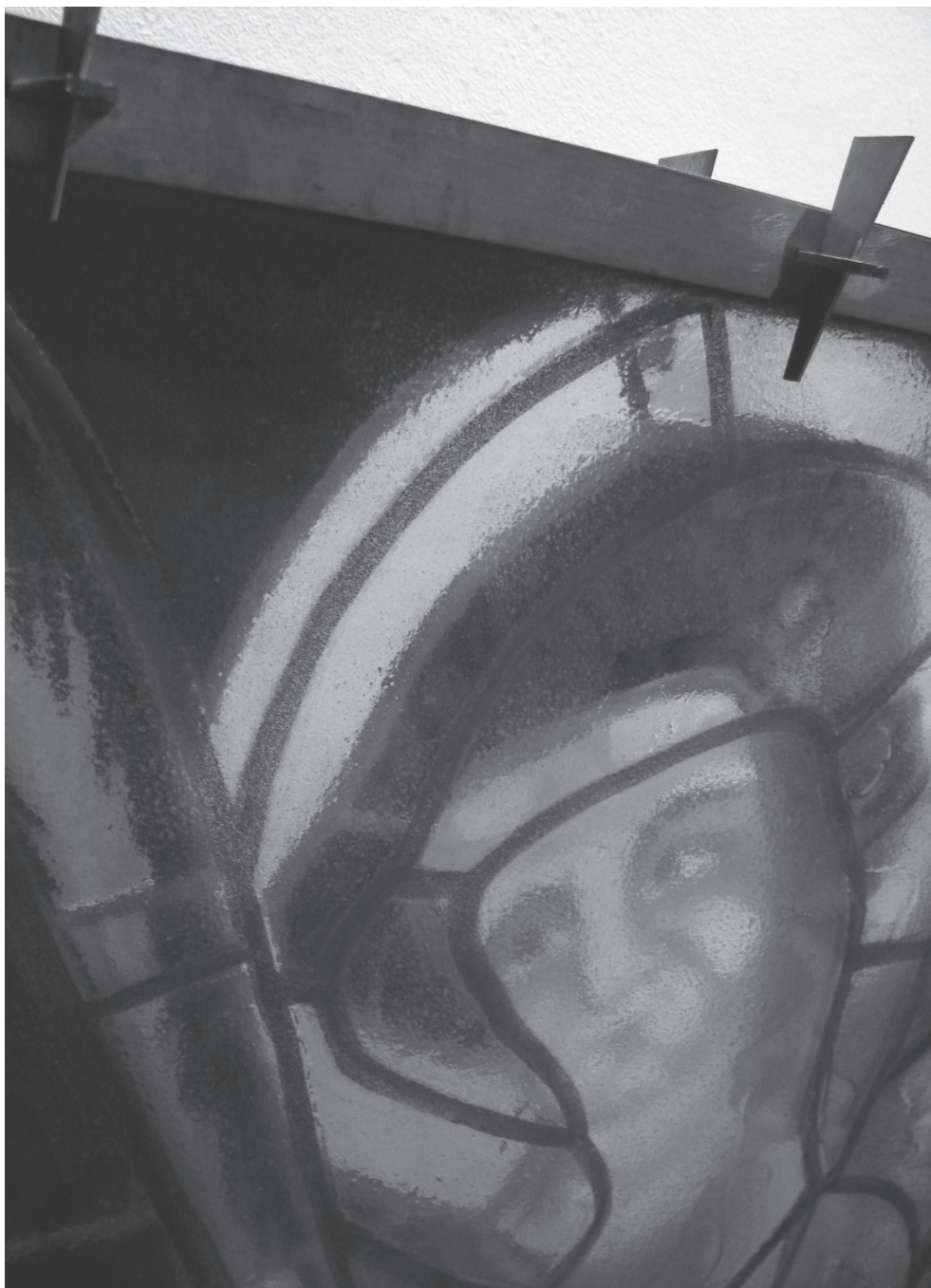
16. Przykład modelowego rozwiązania dla oszklenia zabezpieczającego, Chartres. Fot. M. Czeski
