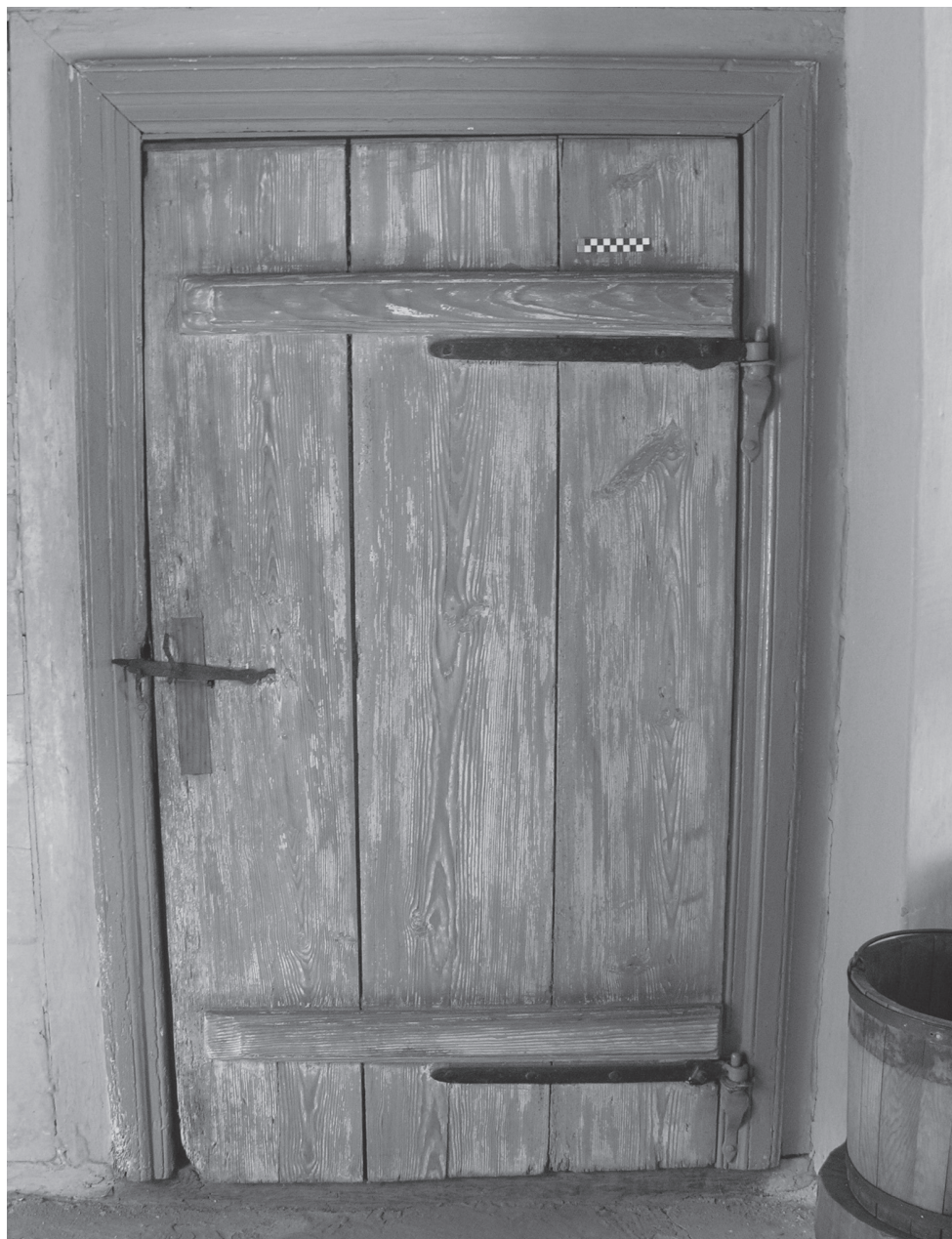
51. Muzeum w Łowiczu. Budynek mieszkalny z d. Złakowa Borowego, koniec XIX w. Drzwi wewnętrzne deskowo-szpungowe z dekoracją ramowo-płycinową awersu przybitą do podkładu deskowego. Wewnętrzny podział ramy ukształtowany w znak krzyża. Lustra ujęte skośnymi płatkami wyrobiono ręcznie w desce płyciny. Fot. A. Cichy
