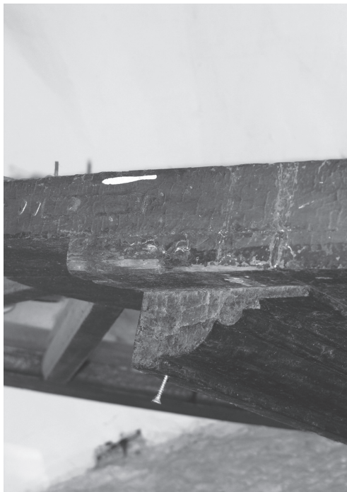
34. Kraków, ul. Floriańska. Wrota przejazdu bramnego-rewers. Skrzydła rozwiązane do podstawy łuku w konstrukcji deskowo-szpungowej, a na wysokości przeszklonego przeswitu w konstrukcji ramowej. Poniżej szczególnie połączeń stolarskich rami przeswitu: szpungowego krytego i czopowego przelotowego. Fot. A. Cichy
