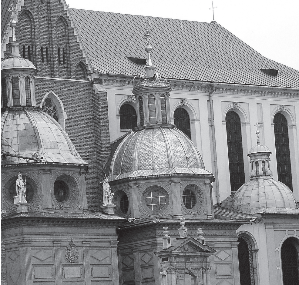
1. Jednym z największych przedsięwzięć z zakresu złocenia ogniowego w Polsce u schyłku XVI w. było pozłocenie metodą ogniową miedzianych łusek pokrywających kopułę Berrecciego, wieńczącą Kaplicę Zygmunta katedry na Wawelu w Krakowie. Fot. S. Safarzyński
