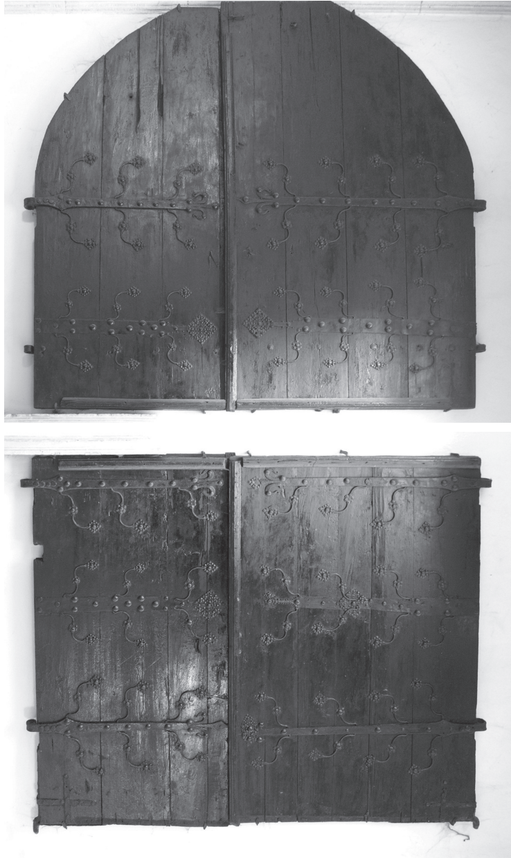
40. Kraków. Kościół Bożego Ciała, kruchta zachodnia. Widok skrzydeł drzwiowych (ok. 1600 r.?) z gotyckimi okuciami pełniącymi funkcję dekoracyjną i konstrukcyjną. Skrzydła eksponowane na przeciwległych ścianach bocznych kruchty składały się na wewnętrzne drzwi deskowe dwupoziomowe dwudzielne, które jeszcze do lat 50. XX w. zamykały wejście z przedsionka do wnętrza nawowego świątyni. Powieszono je częściowo w błędnym układzie – dolne skrzydła obrócono w pionie o 180°, co skorygowano na ilustracji. Fot. A. Cichy
