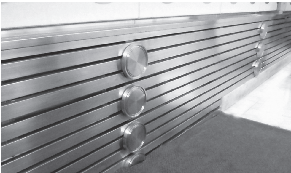
10. Dla jednofazowych stopów miedzi wyniki otrzymywane na drodze polerowania chemicznego nie ustępują w zasadzie wynikom polerowania elektrolitycznego. Na fotografii wypolerowane chemicznie elementy mosiężne kurtyny z sali posiedzeń Senatu RP. Fot. S. Safarzyński
