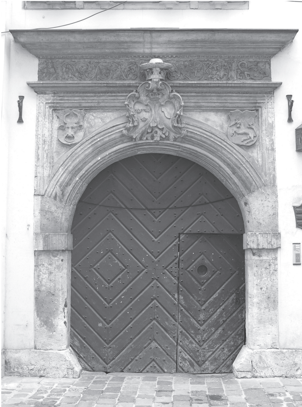
55. Kraków, ul. Kanonicza 15. Dekoracyjny układ szalunku w romby na skrzydle drzwi deskowszpungowych. Fot. A. Cichy
