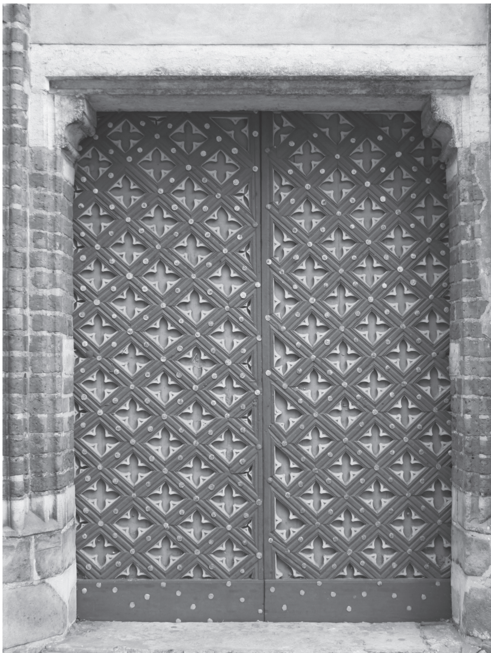
48. Toruń. Bazylika katedralna pw. św. Jana Chrzciciela i św. Jana Ewangelisty. Drzwi deskowo-szpungowe do kruchty północnej, dekorowane drewnianymi kratownicami z czteroliściem, 2. poł. XV w. Fot. A. Cichy
