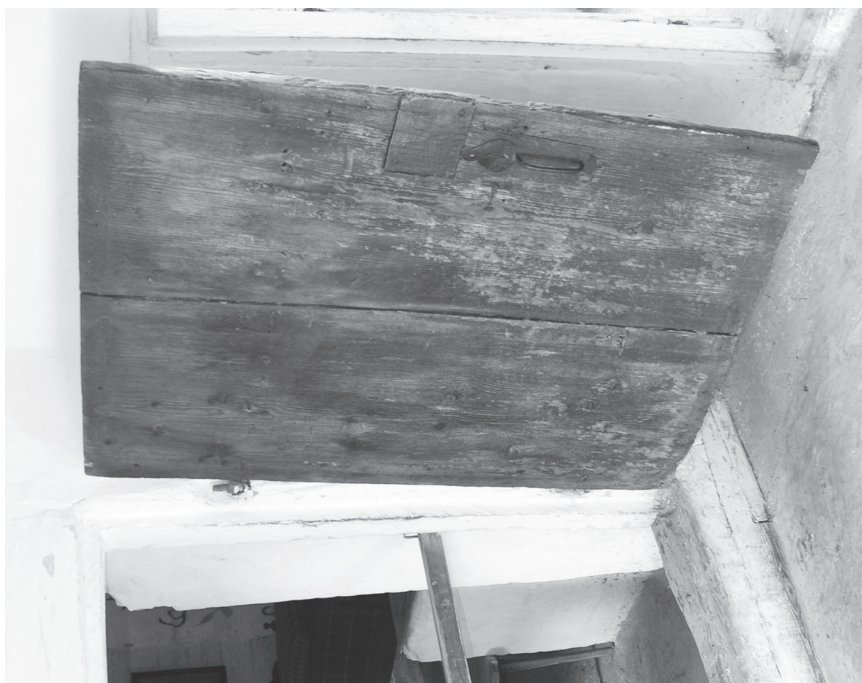
12. Łowicz. Skansen, chata ze wsi Goleńska, druga połowa XVIII w. Drzwi wewnętrzne deskowo-listwowe do izby mieszkalnej. Fot. A. Cichy
