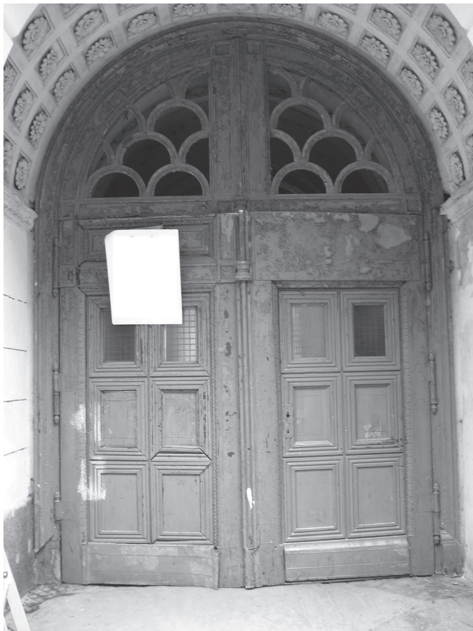
31. Warszawa, ul. Wiejska 21. Kamienica, koniec XIX w. Neorenesansowe wrota w konstrukcji ramowo-płycinowej. Obok przekrój pionowy. Zwraca uwagę złożona budowa odrzwi, ramiaków, a zwłaszcza płycin. Oprac. A. Gromadzka pod kier. autora, 2007 r. Fot. A. Gromadzka. Rys. ze zbior. ZKiTWzD SGGW w Warszawie
