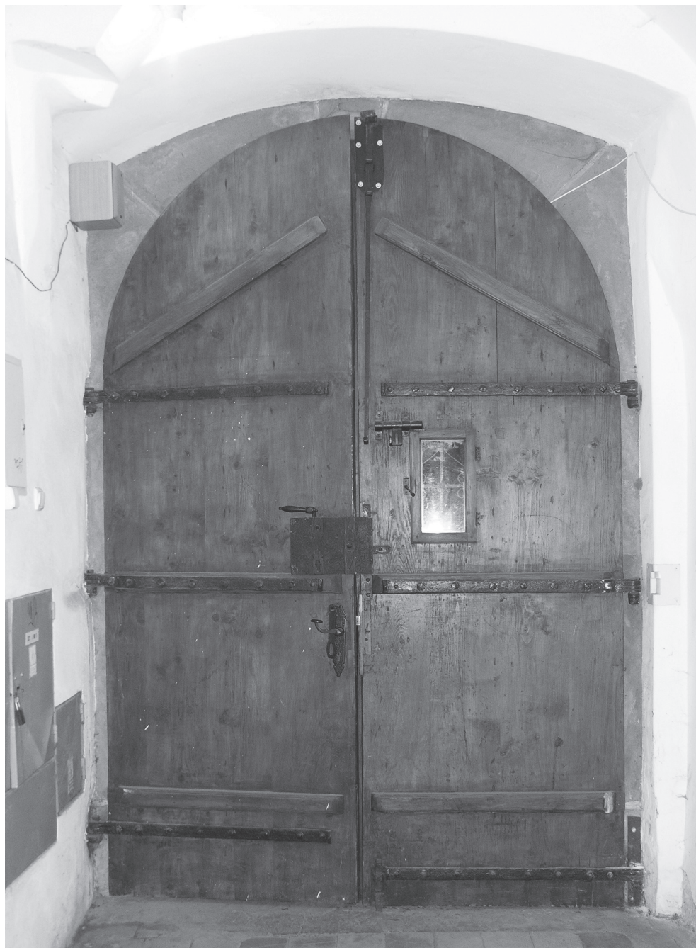
20. Kraków, ul. Grodzka 33. Drzwi deskowo-szpungowe bez odrzwi z górnymi szpungami w układzie skośnym. Fot. A. Cichy
