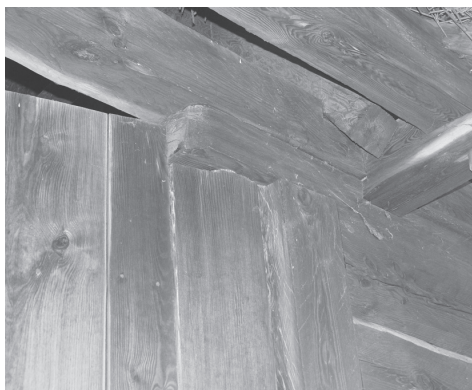
4. Lublin, Muzeum Wsi Lubelskiej (dalej MWL). Stodoła z Janiszowa, druga poł. XIX w. Widok ze wewnątrz strony drzwi biegunowych i szczegóły połączeń czopów deski biegunowej z elementami konstrukcyjnymi ściany. Osadzenie skrzydeł w świetle otworu drzwiowego i ścięcie krawędzi czołowych podwalin odcinkowych umożliwiło ruch wahadłowy skrzydeł. Zwraca uwagę gładka płaszczyzna deskowania i brak poziomych listew usztywniających, osadzonych wyjątkowo na wewnętrznej stronie drzwi – zamykane są od środka. Fot. A. Cichy
