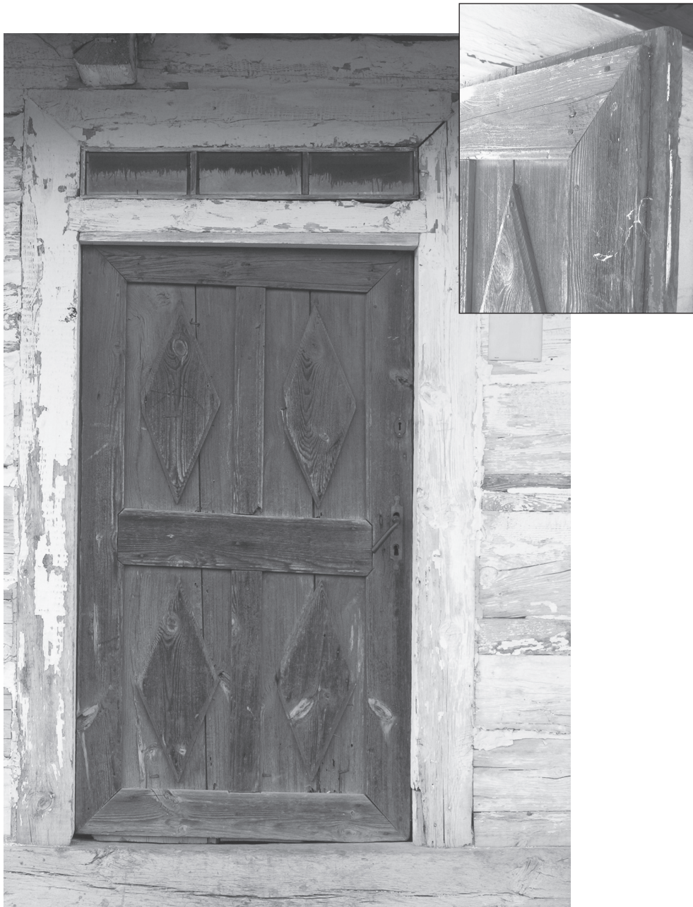
52. Lublin, MWL. Dawny Chrzążów, budynek mieszkalny, 1910-1914. Drzwi deskowo-szpungowe z dekoracją ramowo-płycinową awersu złożoną z ramy i luster – płyciny imitowane są przez deskowanie podkładu. Fot. A. Cichy
