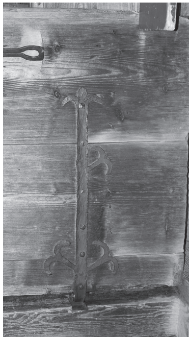
13. Dębno. Kościół parafialny św. Michała Archanioła. Drzwi desko- wo-listwowe wejścia zachodniego i południowego. Skromna deko- racja - wewnętrzna strona drzwi sciana kolorystycznie ze ścianą, awers ozdabiają i wzmacniają zawiasy. Fot. A. Cichy
