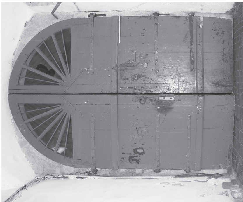
34. Kraków, ul. Floriańska. Wrota przejazdu bramnego-rewers. Skrzydła rozwiązane do podstawy łuku w konstrukcji deskowo-szpungowej, a na wysokości przeszklonego przeswitu w konstrukcji ramowej. Poniżej szczególnie połączeń stolarskich rami przeswitu: szpungowego krytego i czopowego przelotowego. Fot. A. Cichy
