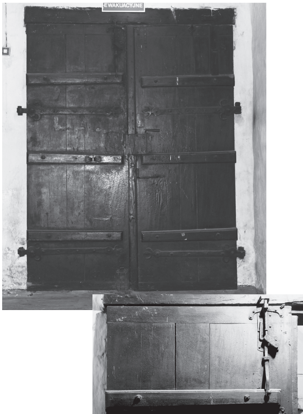
23. Toruń. Bazylika katedralna św. Jana Chrzciciela i św. Jana Ewangelisty, kruchta północna. Drzwi deskowo-szpunkowe z listwą czołową, bez odrzwi. Fot. A. Cichy
