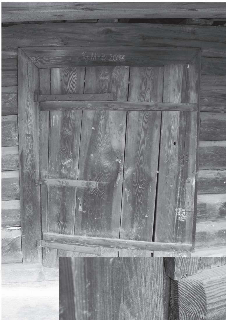
21. Lublin, MWL. Kuźnia z Ciosm, 1924 r. Drzwi de- skowo-szpungowe z zawiasami an- tywłamaniowymi. Fot. A. Cichy
