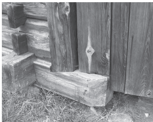
4. Lublin, Muzeum Wsi Lubelskiej (dalej MWL). Stodoła z Janiszowa, druga poł. XIX w. Widok ze wewnątrz strony drzwi biegunowych i szczegóły połączeń czopów deski biegunowej z elementami konstrukcyjnymi ściany. Osadzenie skrzydeł w świetle otworu drzwiowego i ścięcie krawędzi czołowych podwalin odcinkowych umożliwiło ruch wahadłowy skrzydeł. Zwraca uwagę gładka płaszczyzna deskowania i brak poziomych listew usztywniających, osadzonych wyjątkowo na wewnętrznej stronie drzwi – zamykane są od środka. Fot. A. Cichy
