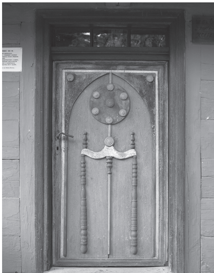
71. Kraków, ul. Grodzka 33. Drzwi deskowo-szpungowe z dekoracją ramowo-płycinową awersu i elementami gotowymi wykonanymi z drewna i mosiądzu, 2. poł. XIX w. Fot. A. Cichy
