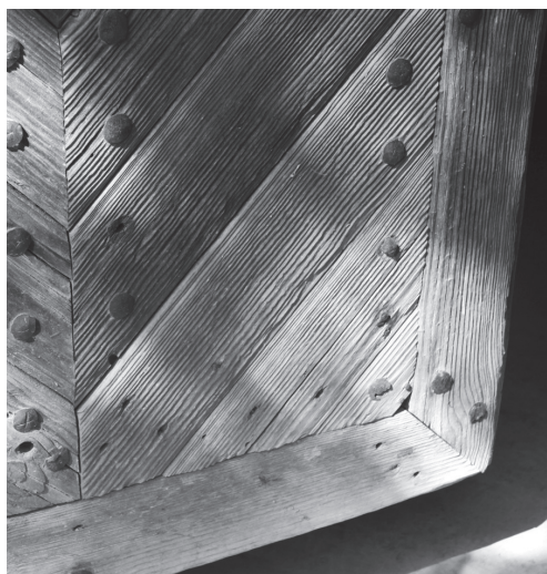
39. Przykłady dekoracji awersu skrzydeł drzwiowych, wykonanej z głowaczki, na podkładzie z ozdobnego deszkowania. A – Niedzica, spichlerz, koniec XVIII w., B – Kraków, kościół św. Marcina, C – Lublin, MWL, zagroda z Niemiec, 1896 r. Fot. A. Cichy
