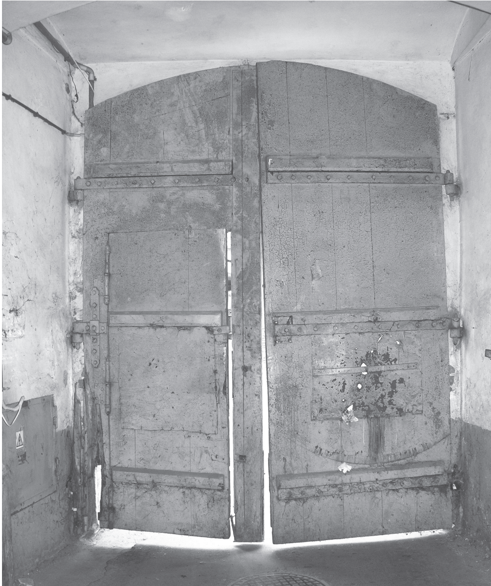
33. Warszawa, ul. Brzeska 21. Wrota przejazdu bramnego, ok. 1890. Drzwi bez odrzwi, o skrzydłach rozwiązanych w konstrukcji deskowo-szpungowej (prawe i furtka lewego) oraz ramowo-płycinowej (lewe w części powyżej furtki). Deski w układzie pionowym, wypełniające ramę, nie mają klasycznej formy płyciny o wycofanym licu, z lustrem pośrodku, ale są z nią obustronnie zlicowane, stanowiąc podkład pod nałożoną dekorację ramowo-płycinową awersu i usztywnienie szpungą lewej strony skrzydła, którą osadzono na tej samej wysokości, jak w sąsiednim skrzydle. Fot. A. Cichy
