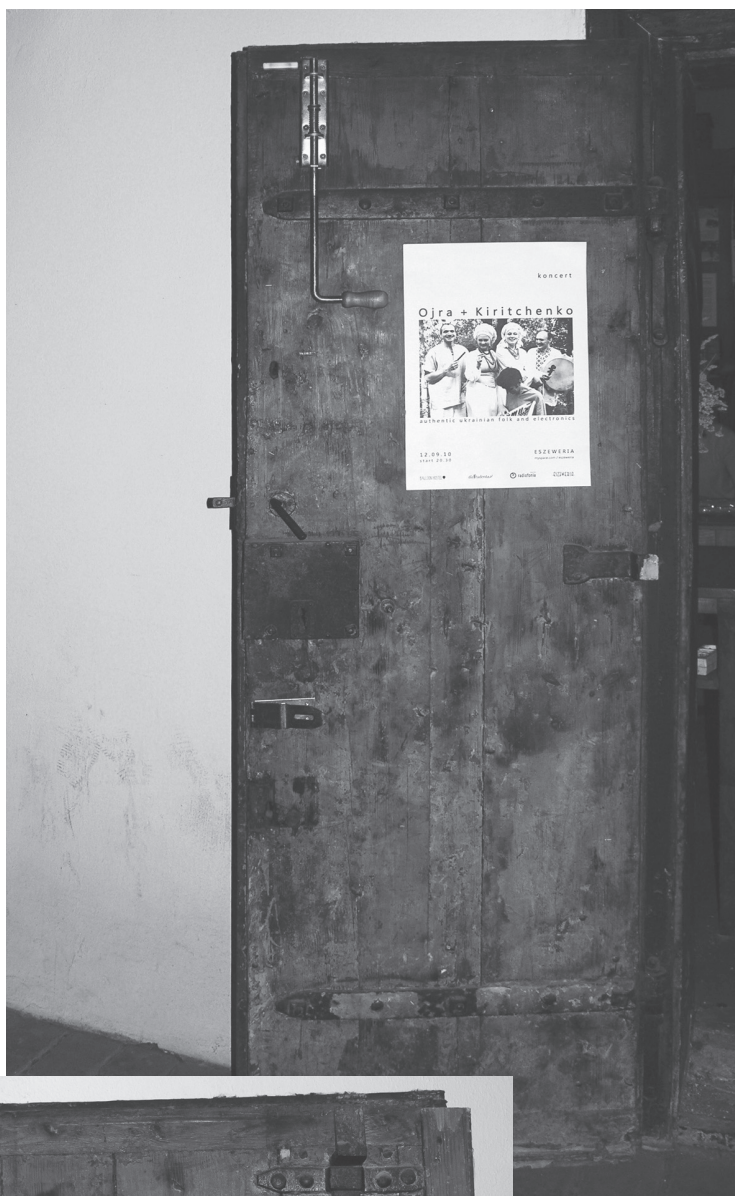
22. Kraków, ul. Bracka 5. Drzwi deskowe z listwą czołową. Fot. A. Cichy
