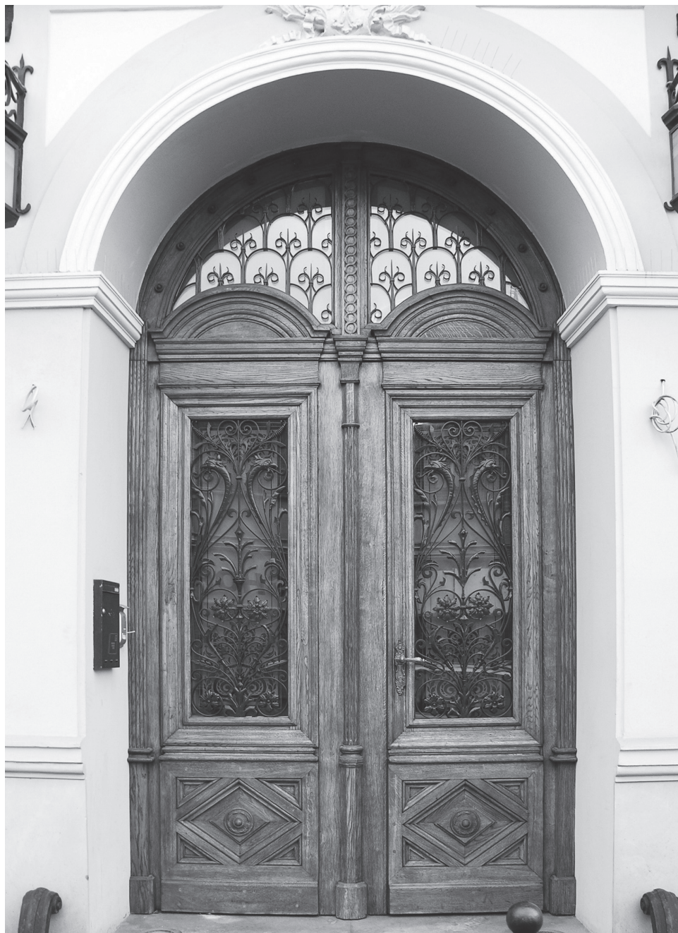
64. Wrota ramowo-płycinowe o dekoracji architektonicznej awersu: Łódź, ul. Piotrkowska 104/104a, koniec XIX w.; Warszawa, ul. Zielna 49, pałac Jakuba Janasza, 1874-1875, proj. J. Heurich st. (replika drzwi). Fot. A. Cichy
