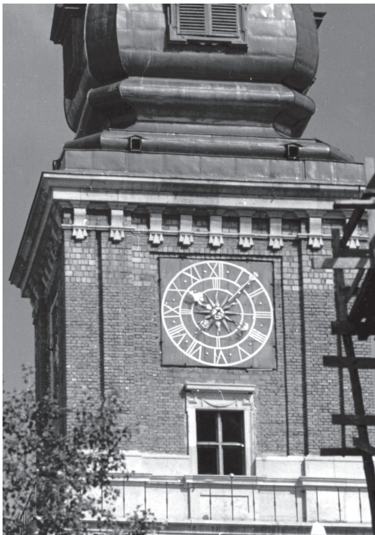
2. W latach 70. ubiegłego wieku pokryto złotem, metodą galwaniczną, niektóre metalowe elementy wystroju architektonicznego Zamku Królewskiego w Warszawie. Fot. J. Skowroński
