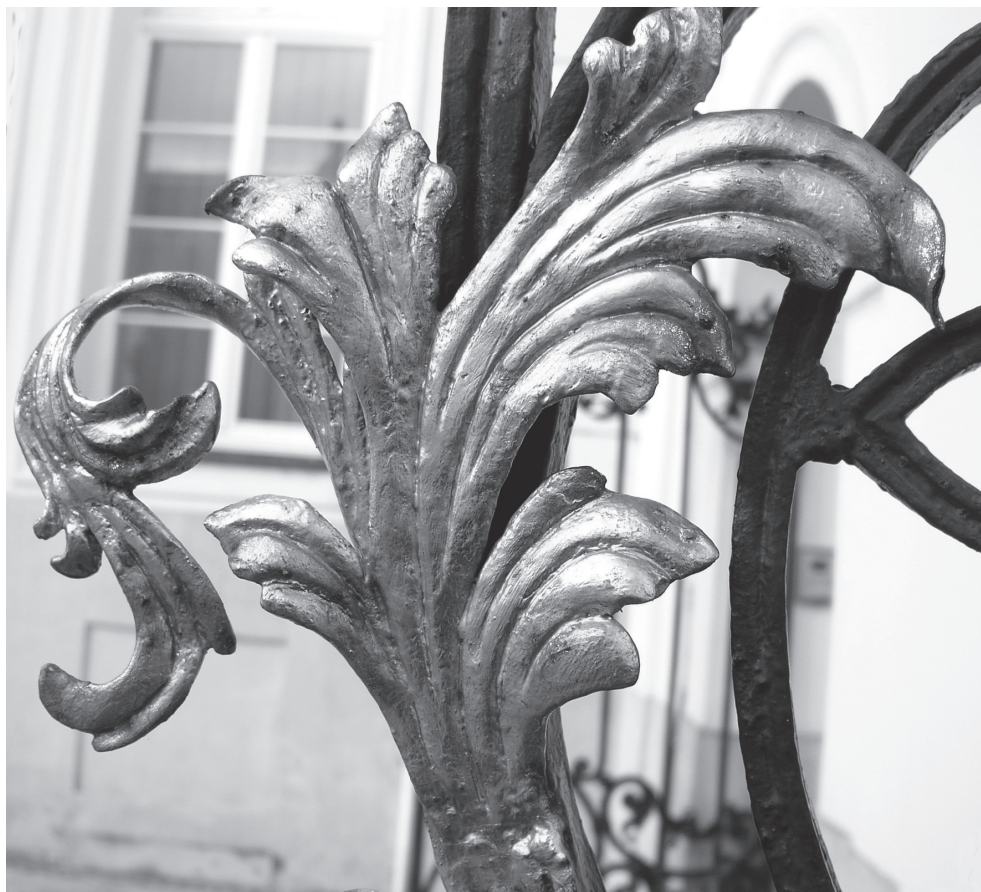
15. Płatki złota transferowego nałożone na elementy dekoracyjne bramy wykonanej z żelaza. Fot. S. Safarzyński
