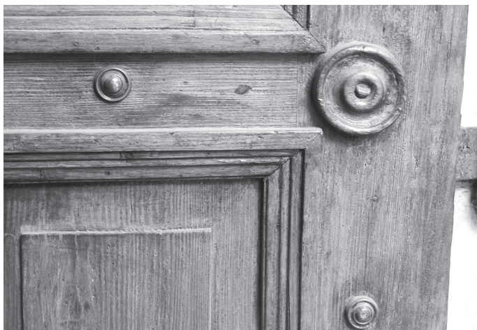
71. Kraków, ul. Grodzka 33. Drzwi deskowo-szpungowe z dekoracją ramowo-płycinową awersu i elementami gotowymi wykonanymi z drewna i mosiądzu, 2. poł. XIX w. Fot. A. Cichy
