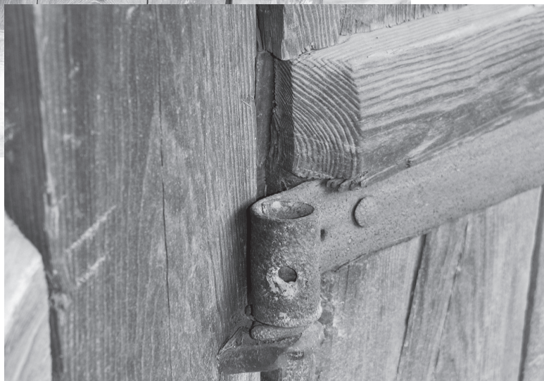
21. Lublin, MWL. Kuźnia z Ciosm, 1924 r. Drzwi de- skowo-szpungowe z zawiasami an- tywłamaniowymi. Fot. A. Cichy
