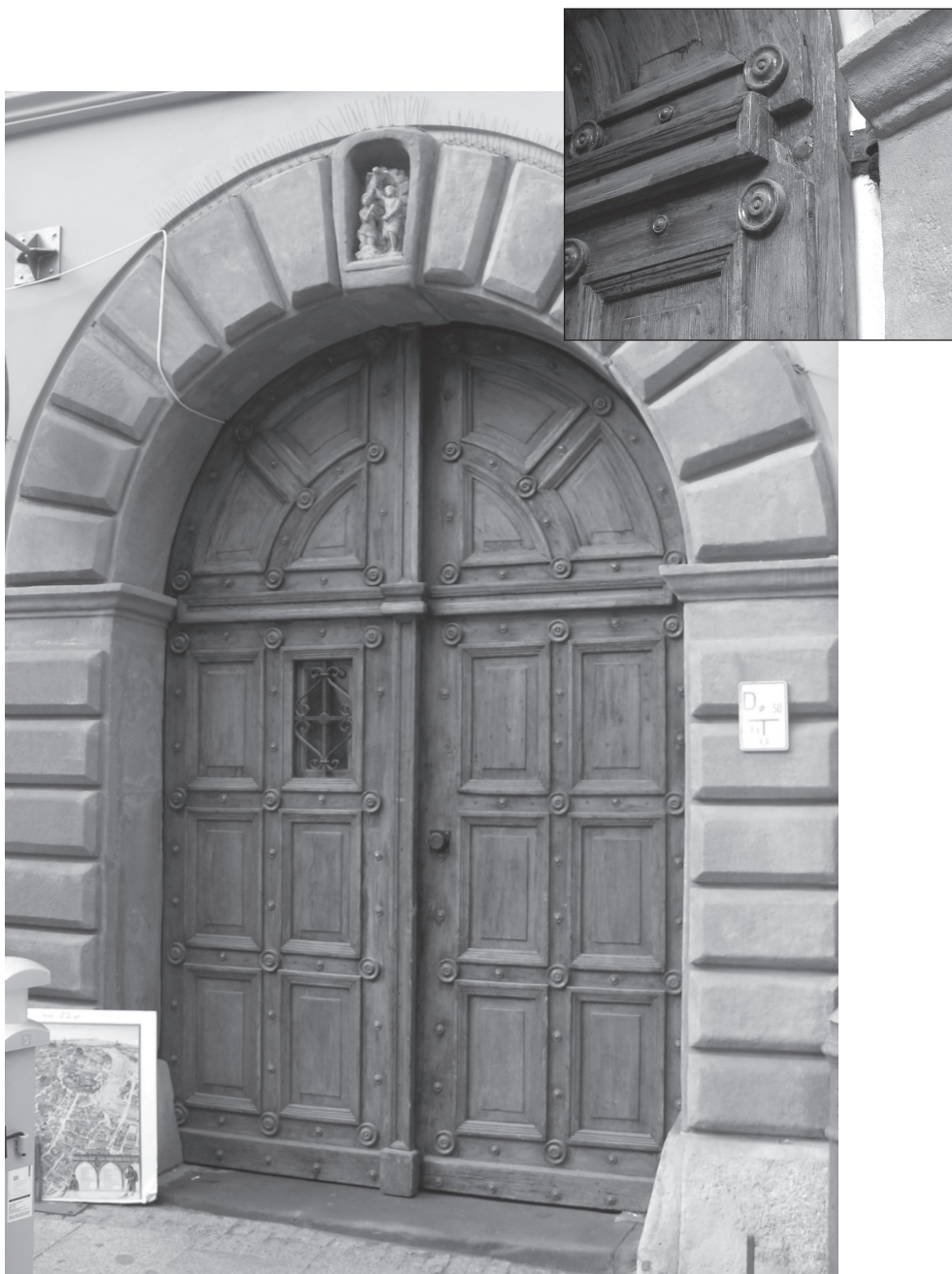
50. Kraków, ul. Grodzka 33. Drzwi deskowo-szpungowe z dekoracją ramowo-płycinową awersu przybitą do podkładu z desek, 2. poł. XIX w. Montaż ramy w niewielkim oddaleniu od zewnętrznych krawędzi skrzydeł tworzy rodzaj przyłgi. Fot. A. Cichy
