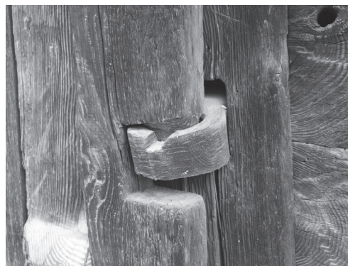
7. Lublin, MWL. Roztocze, Huta Dzierżyńska. Drzwi biegunowe, pierwsza połowa XIX w. Widok drzwi do stodoły i szczegóły połączeń czopów deski biegunowej z jarzmem i panewką przypominającego zasadą działania łożysko ślizgowe wzdłużne. Fot. A. Cichy
