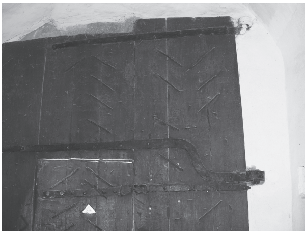
9. Niedzica. Zamek. Rewers drzwi deskowych bramy głównej zamku dolnego. Szerokie deski połączone zawiasami i klamrami. Fot. A. Cichy
