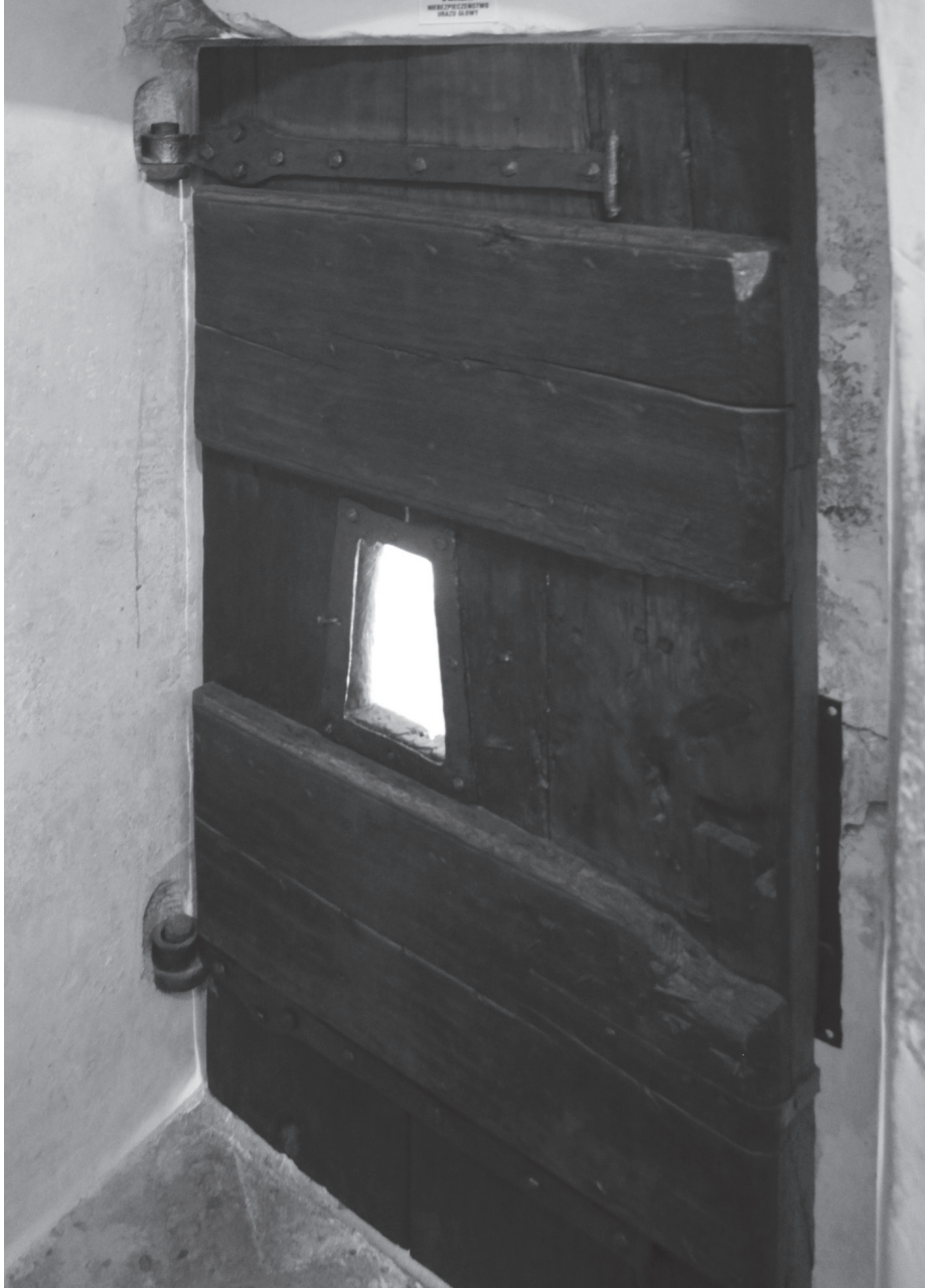
91. Gdańsk. Muzeum Bursztynu. Nowe drzwi deskowe (po lewej), imitujące budowę oryginalnych drzwi zdwojonych, wyróżniają się, oprócz sposobu połączenia desek poziomych z pionowymi, gładką powierzchnią i powtarzalnością wymiarową wszystkich części, osiągniętą w wyniku obróbki maszynowej. Fot. A. Cichy
