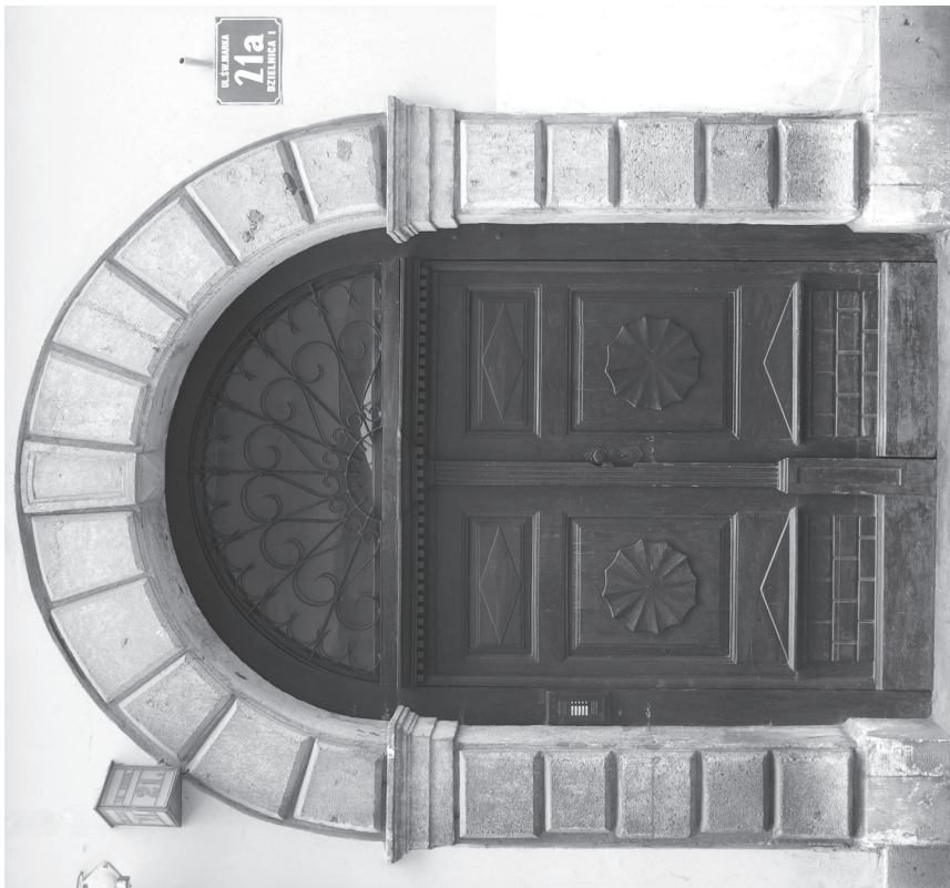
63. Kraków, ul. Św. Marka 21a. Wrota w konstrukcji deskowej z opierzeniem dekoracją ramowo-płycinową i detalem architektonicznym, XIX w. oraz Bielsko-Biała, ul. 3 Maja 3. Neorenesansowe drzwi ramowo-płycinowe z dekoracją architektoniczną awersu. Kamienica K. T. Forstera, 1898 r., proj. K. Korn. Fot. A. Cichy
