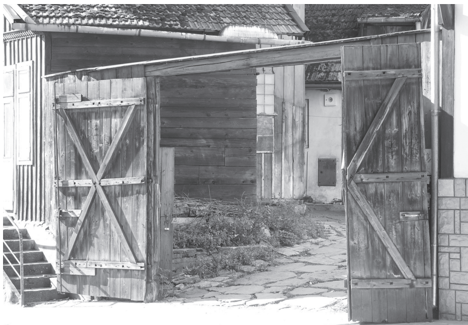
15. Szczawnica, ul. Szalaya 15. Drzwi deskowe listwowo-zastrzałowe. Fot. A. Cichy
