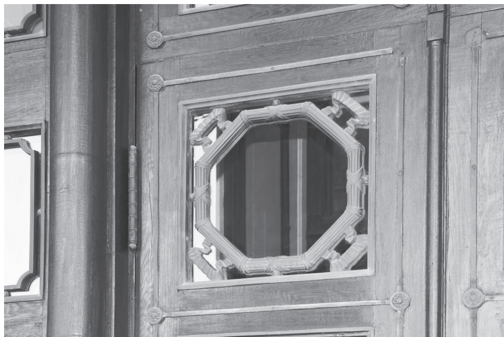
80. Warszawa. Pałac Kultury i Nauki. Drzwi ramowo-płycinowe szklone wejścia głównego. Fot. A. Cichy
