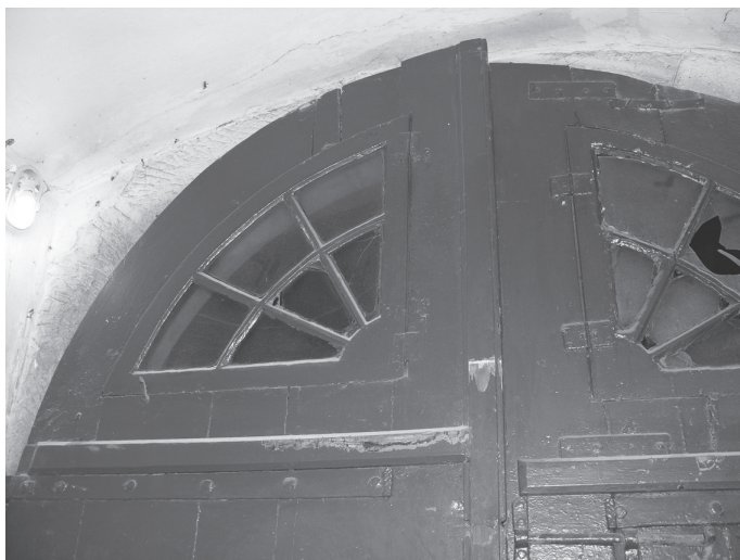
76. Kraków, ul. Grodzka 39. Drzwi deskowo-szpungowe z opierzeniem dekoracją ramowo-płycinową awersu i przeszwitem wyciętym w deskach podkładu. Fot. A. Cichy
