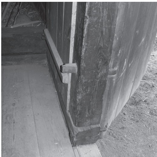
8. Lublin, MWL. Roztocze, Teodorówka. Drzwi biegunowe, przełom XIX i XX w. Awers drzwi i widok połączenia dolnego czopa deski biegunowej z panewką. Skrzydło jest zabezpieczone przed wypadnięciem czopa z panewki za pomocą metalowej obejmy osadzonej w podwalinie i przechodzącej przez otwór w desce. Fot. A. Cichy
