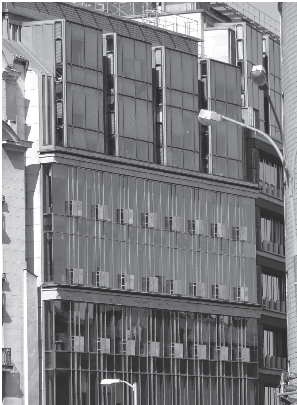
24. Konstrukcje z aluminium w budownictwie sprowadzają się obecnie do szeregu wyrobów: bloki okienne, wewnętrzne instalacje, witraże, konstrukcje ze „szkła i aluminium”. Fot. S. Safarzyński
