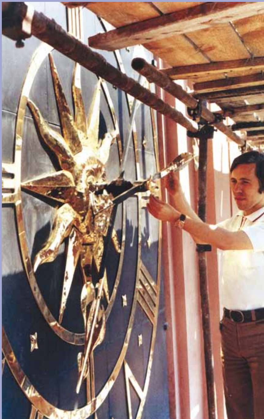
6. Pozłoczone galwanicznie elementy zegara Zamku Królewskiego w Warszawie
