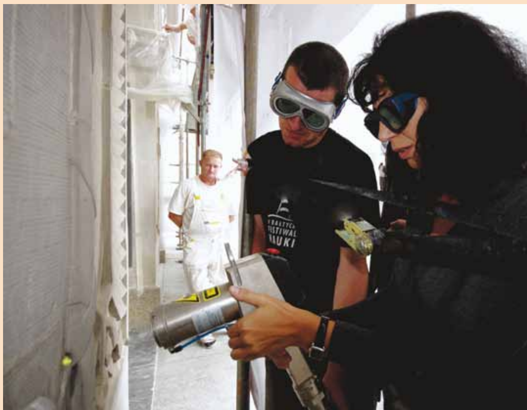
7. Czyszczenie przy użyciu wiązki laserowej płaskorzeźb z piaskowca szydłowieckiego na filarach Grobu Nieznanego Żołnierza w Warszawie
