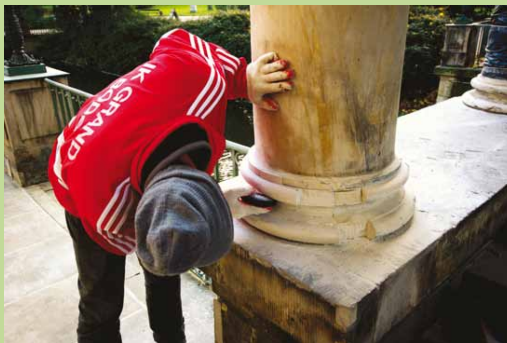
6. Ręczne wyprowadzanie pierwotnych kształtów na powierzchniach w kamiennych bazach kolumn
