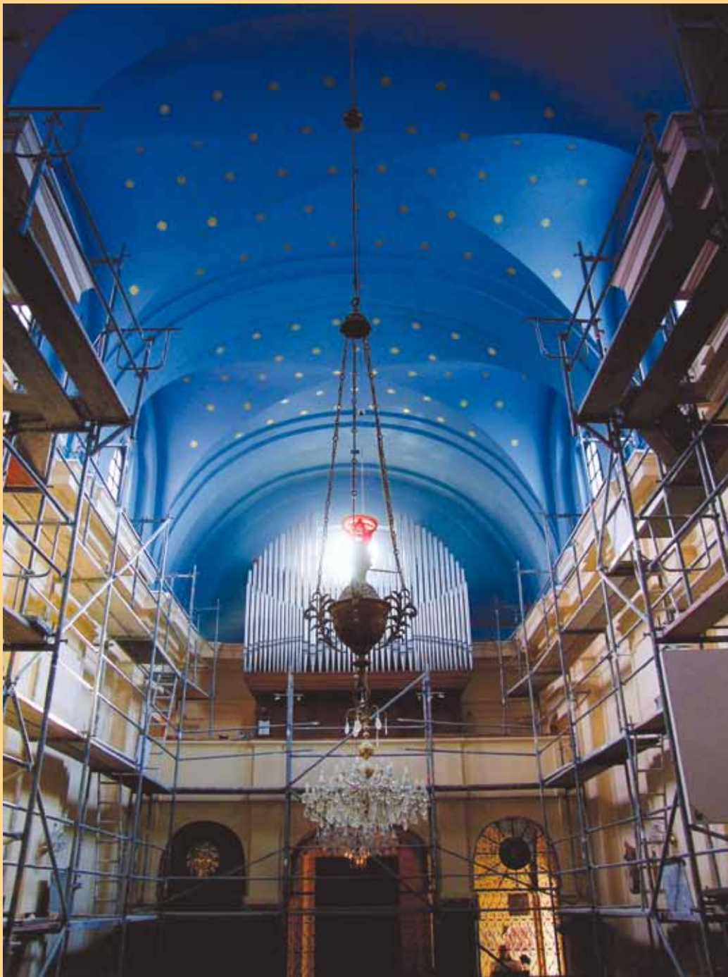
1. Kościół ojców bonifratrów w Warszawie podczas odtwarzania pierwotnego wystroju kolorystycznego – całe wnętrze kościoła było wymalowane po drugiej wojnie światowej na biało i niedawne badania stratygrafii tynków wykazały, że pionowe ściany były w kolorze jasnego ugru, a sklepienie niebieskie usłane złotymi gwiazdami
