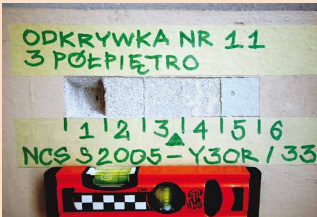
2. Odkrywka stratygraficzna w tynku na wewnętrznej ścianie pomieszczeń trybuny honorowej na Torze Wścigów Konnych w Warszawie - odsłonięty pierwotny kolor to nr 3 oznaczony w systemie NCS numerem S2005Y30R
