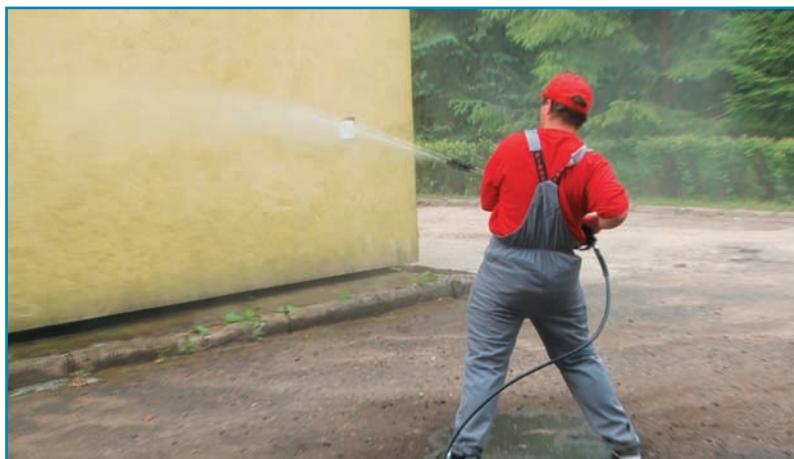
Mycie elewacji myjką wysokociśnieniową.
