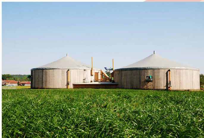
Biogazownie rolnicze są bardzo popularne w krajach zachodnich, w Polsce widok takich instalacji na wsi należy jeszcze do rzadkości
