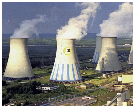
Rysunek 36. Chłodnie kominowe elektrowni, biały dym, to przechłodzona para wodna
