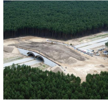
przejście dla zwierząt nad drogą szybkiego ruchu
