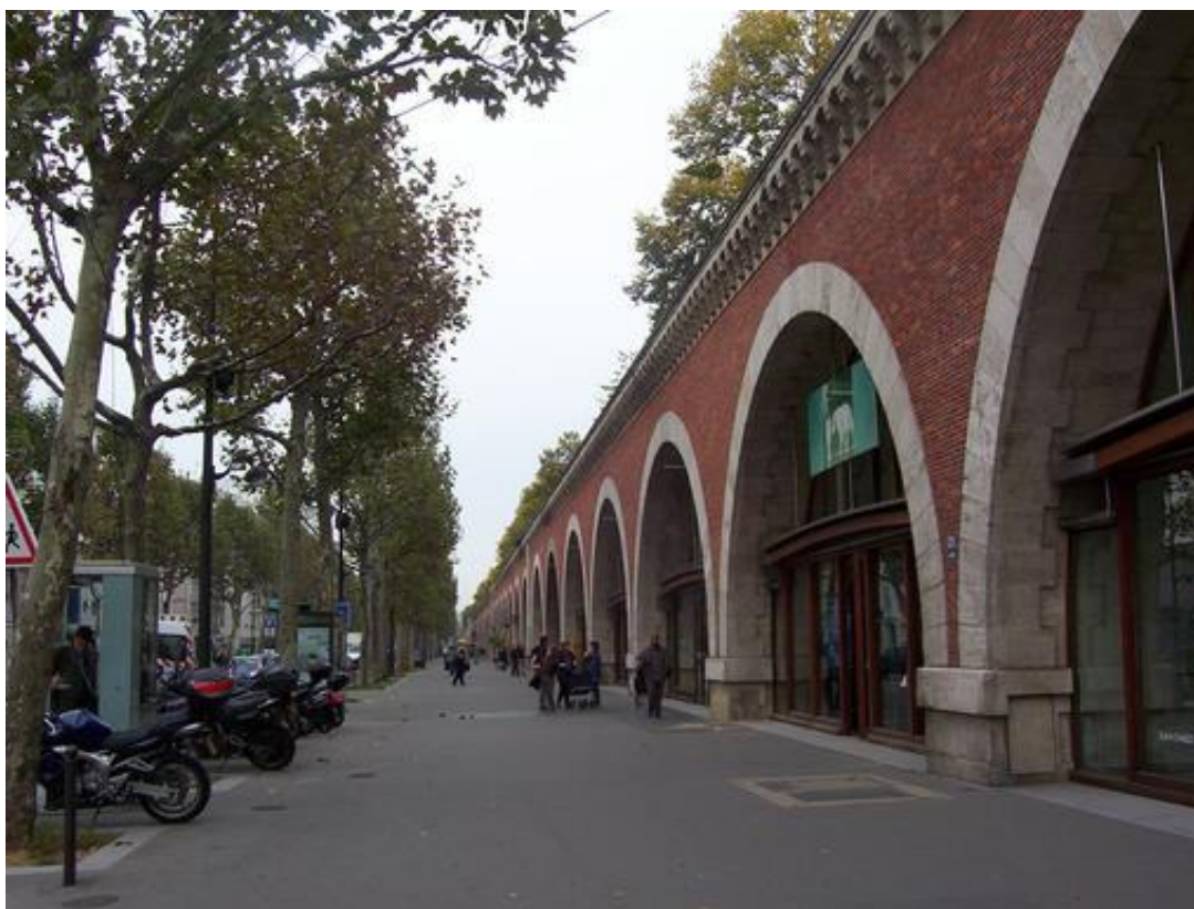
Ryc. 8. Viaduct des Arts. U góry widoczne korony drzew Promenade Plantée.
