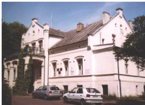
Fot. Dworek w Choceniu (zdjęcie z archiwum szkoły. Dworek w 2010r uległ częściowemu zniszczeniu podczas pożaru)
