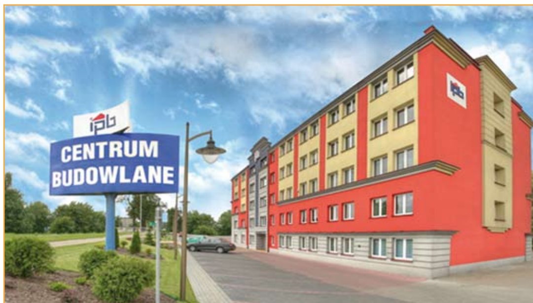
Siedziba Łławskiego Przedsiębiorstwa Budowlanego IPB Sp. z o.o. w Łławie przy ul. Lubawskiej 3
