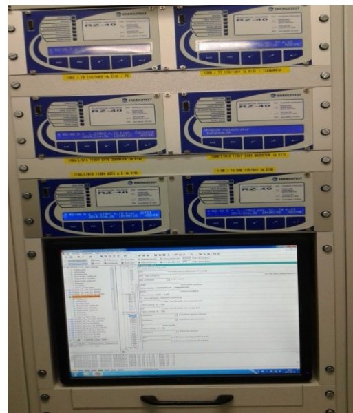
System kontroli parametrów i rejestrowania zakłóceń Urządzeń elektroenergetycznych
