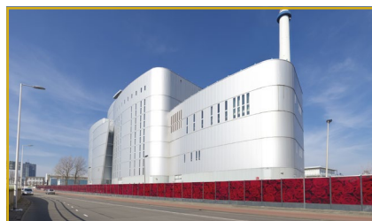
Rys. 5.14. Nowoczesna spalarnia śmieci w Rotterdamie.
