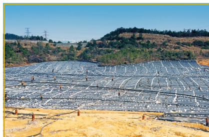
Rys. 5.13. Niecka składowiska musi być wyłożona nieprzepuszczalną folią.
