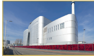
Rys. 5.14. Nowoczesna spalarnia śmieci w Rotterdamie.
