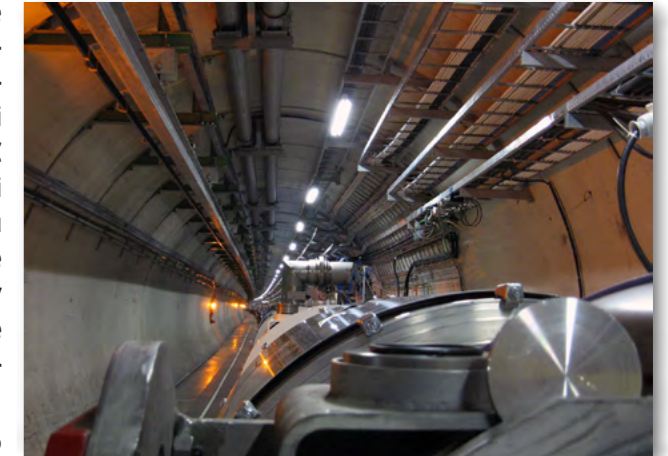
Rys.11.8. Wnętrze tunelu LHCw CERN pod Genewą.
