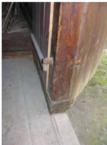
39. Lublin, MWL. Roztocze, Teodorówka. Drzwi biegunowe, przełom XIX i XX w. Awers drzwi i widok połączenia dolnego czopa deski biegunowej z panewką. Skrzydło jest zabezpieczone przed wypadnięciem czopa z panewki za pomocą metalowej obejmy osadzonej w podwalinie i przechodzącej przez otwór w desce. Fot. A. Cichy, 2010 r.
