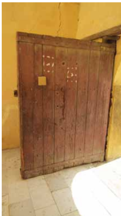
18. Egipt, Naclum-Fajum. Drzwi biegunowe z odrzwiami będącymi częścią drewnianego stelaża nałożonego na ścianę. Fot. W. Weker, maj 2013 r.
