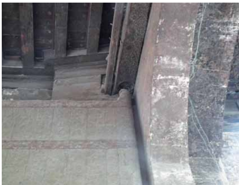
17. Kair. Brama miejska z widokiem jednoskrzydłowych wrót biegunowych nakładanych. Taflę skrzydła utworzoną z kantówek spinają żelazne płaskowniki wpuszczone w pokład. Fot. W. Weker, maj 2013 r.
