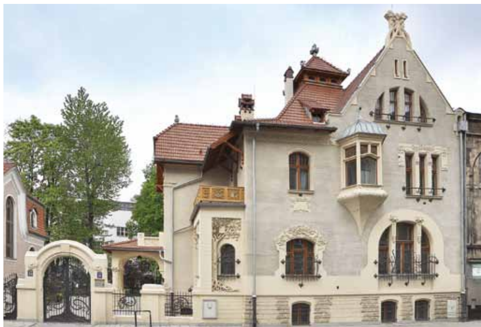
Widok elewacji willi od strony ulicy Wólczańskiej – stan po konserwacji. Fot. P.G. Mądrach
