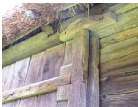
38. Lublin, MWL. Roztocze, Huta Dzierżyńska. Drzwi biegunowe, pierwsza połowa XIX w. Widok drzwi do stodoły i szczegóły połączeń czopów deski biegunowej z jarmem i panewką przypominającego zasadę działania łożysko ślizgowe wzdłużne. Fot. A. Cichy, 2010 r.
