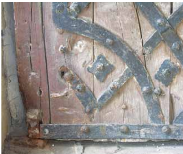
40. Niedzica. Zamek dolny. Wrota z żelaznymi biegunami i zawiasą pasową. Połowa XVIII w. (?). Płaskownik dolnego bieguna ujmuje krawędź deski z obu stron. Zastosowano również zawiasę pasową zabezpieczającą skrzydło przed wypchnięciem po wysunięciu się dolnego czopa z płytkiej panewki. Brak osiowości pomiędzy czopami w relacji do bocznej krawędzi taflii wymusił duże luzy w gniazdach. Fot. A. Cichy 2013 r.
