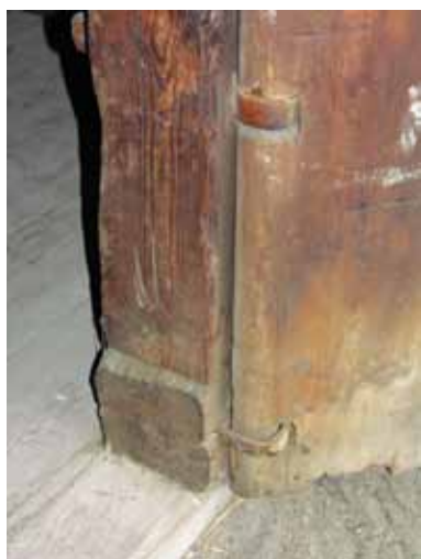
39. Lublin, MWL. Roztocze, Teodorówka. Drzwi biegunowe, przełom XIX i XX w. Awers drzwi i widok połączenia dolnego czopa deski biegunowej z panewką. Skrzydło jest zabezpieczone przed wypadnięciem czopa z panewki za pomocą metalowej obejmy osadzonej w podwalinie i przechodzącej przez otwór w desce. Fot. A. Cichy, 2010 r.
