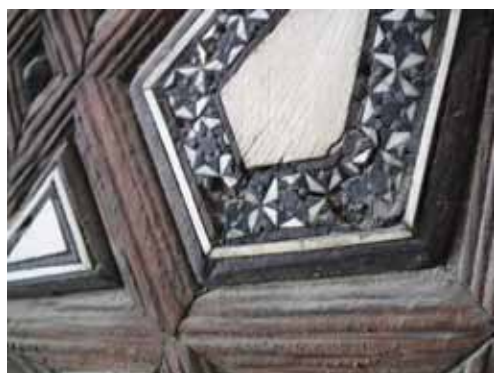
20. Kair. Meczet al-Muajjada (Czerwony Meczet), 1415-1421 r. Wejście do Mauzoleum al-Muajjada. Widok drzwi biegunowo ramowo-płycinowych oraz szczegóły dekoracji i połączenia górnego czopa ramiaka biegunowego z nadprożem. Do geometrycznej dekoracji awersu wykorzystano drewno inkrustowane kością i kamieniem. Czopy ramiaka biegunowego osadzone są w kamiennym progu i drewnianym nadprożu – wymiennym elemencie odrzwi. Fot. W. Weker, maj 2013 r.
