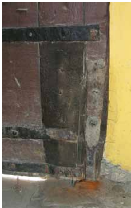
40. Niedzica. Zamek dolny. Wrota z żelaznymi biegunami i zawiasą pasową. Połowa XVIII w. (?). Płaskownik dolnego bieguna ujmuje krawędź deski z obu stron. Zastosowano również zawiasę pasową zabezpieczającą skrzydło przed wypchnięciem po wysunięciu się dolnego czopa z płytkiej panewki. Brak osiowości pomiędzy czopami w relacji do bocznej krawędzi taflii wymusił duże luzy w gniazdach. Fot. A. Cichy 2013 r.
