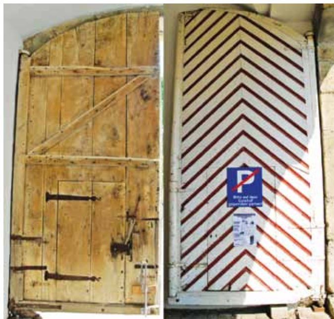
30. Niemcy, Browar zamku Rheder, obwód Höxter. Skrzydło wrót biegunowych z żelaznym i drewnianym czopem (awers i rewers). Tafla rozwiązana w konstrukcji deskowo-listwowej z zastrzałem, ukrytą furtką na zawiasach i dekoracyjnym opierzeniem awersu deskami szalunkowymi; fot. za: T. Volmer, op. cit., s. 24.
