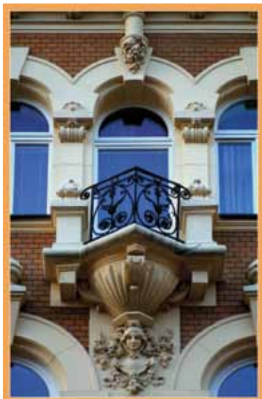
To tylko fragment bogatego sztukatorskiego wystroju na fasadzie kamienicy przy ulicy Foksal
