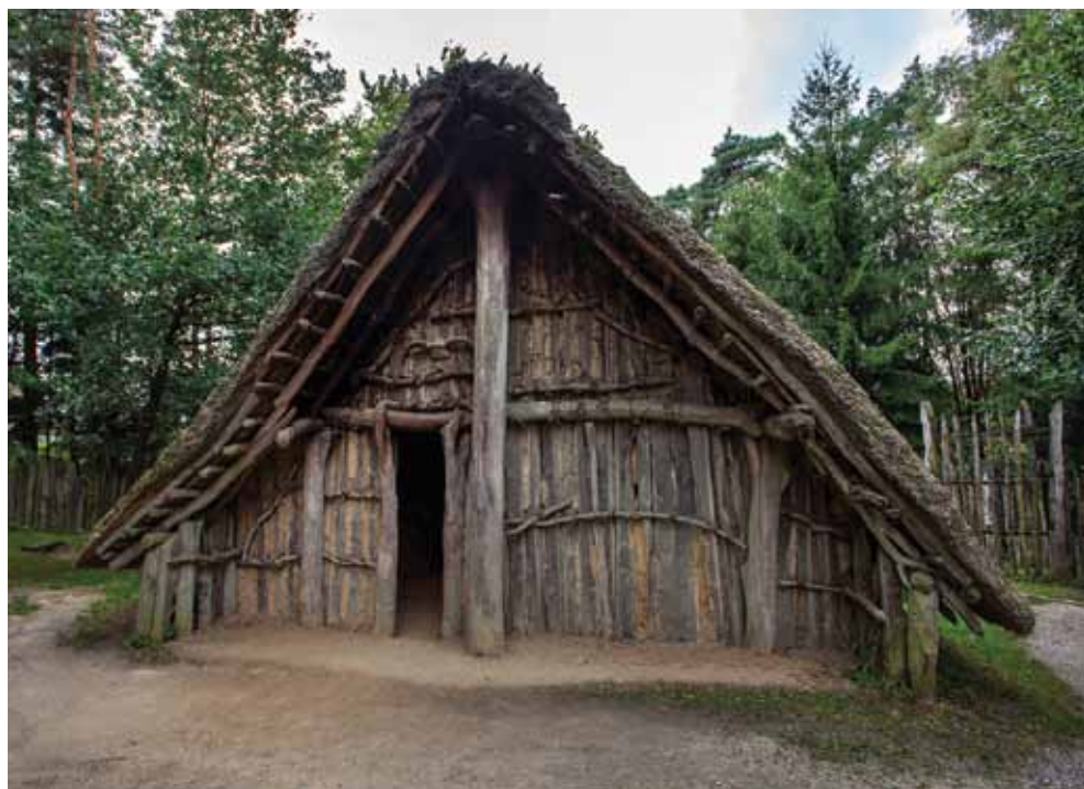
5. Niemcy, Archäologischen Freilichtmuseum Oerlinghausen. Rekonstrukcja długiego domu z okresu neolitu, o ścianach wykonanych w konstrukcji słupowo-palisadowej. Odpowiednio przycięte pnie i konary przekształcano w sochy, które – osadzone głęboko w ziemi, jak drzewa – tworzyły główne elementy konstrukcyjne budynku dźwigające słomę w kalenicy i oczepy ścian. Powszechnie stosowane jest także łączenie cienkimi gałązkami (wiklinowymi lub z innych drzew i krzewów), którymi jak sznurem obwiązywano drobniejsze elementy konstrukcji zastępując nieznanne jeszcze łączniki kołkowe. Fot. za: http://de.Wikipedia.org/Wiki/Jungsteinzeit ; autor: Grugerio-2012
