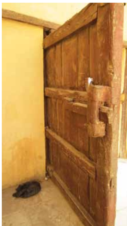
18. Egipt, Naclum-Fajum. Drzwi biegunowe z odrzwiami będącymi częścią drewnianego stelaża nałożonego na ścianę. Fot. W. Weker, maj 2013 r.
