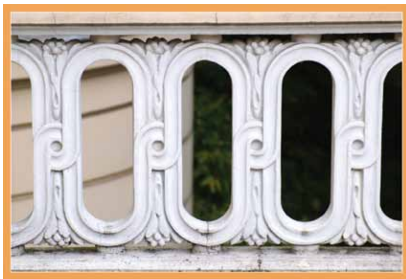
Balustrada wykonana z odlewów cementowych zamontowana na tarasie w kamienicy przy alei Róż
