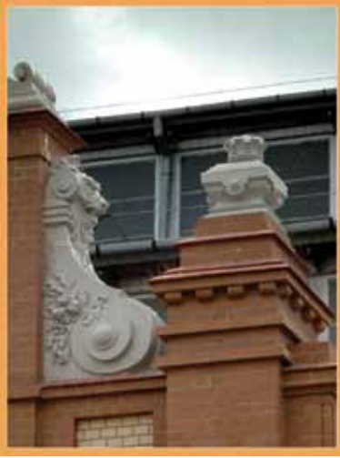
Fragment zrekonstruowanego w 2012 r. szczytu nad północnym wejściem do Hali Mirowskiej
