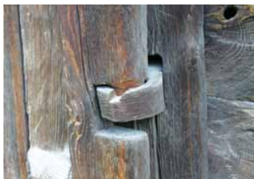
38. Lublin, MWL. Roztocze, Huta Dzierżyńska. Drzwi biegunowe, pierwsza połowa XIX w. Widok drzwi do stodoły i szczegóły połączeń czopów deski biegunowej z jarmem i panewką przypominającego zasadę działania łożysko ślizgowe wzdłużne. Fot. A. Cichy, 2010 r.
