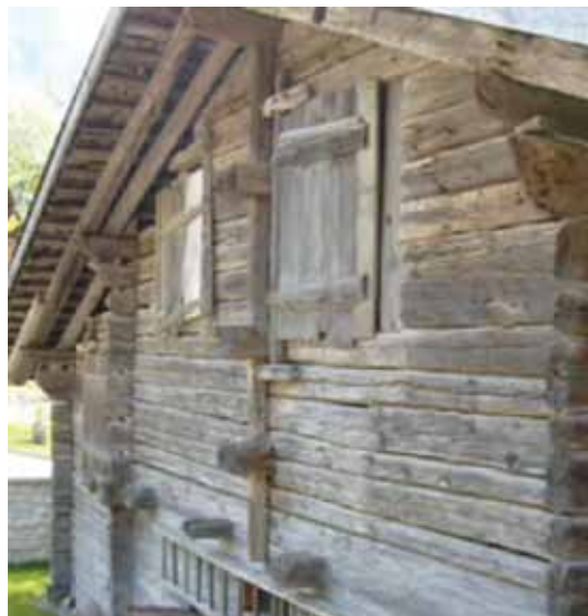
31. Szwajcaria, Grindelwald. Drzwi biegunowe w ścianie szczytowej prowadzące do pomieszczeń gospodarczych na poddaszu. Zachowane w stanie niemal pierwotnym budynki pełnią dzisiaj rolę żywych skansenów
