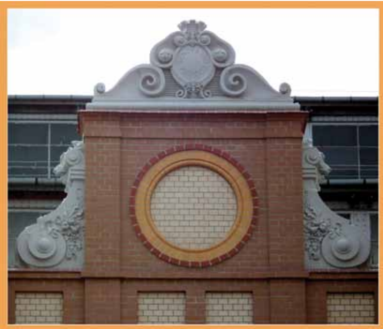
Zrekonstruowany w 2012 r. szczyt nad północnym wejściem do Hali Mirowskiej
