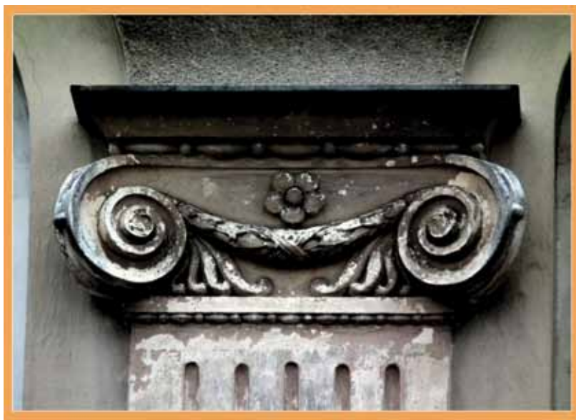
Prosty kapitel wieńczący kanelowany pilaster, wykonany z wypraw wapienno-cementowo-piaskowych na elewacji kamienicy przy ulicy Marszałkowskiej
