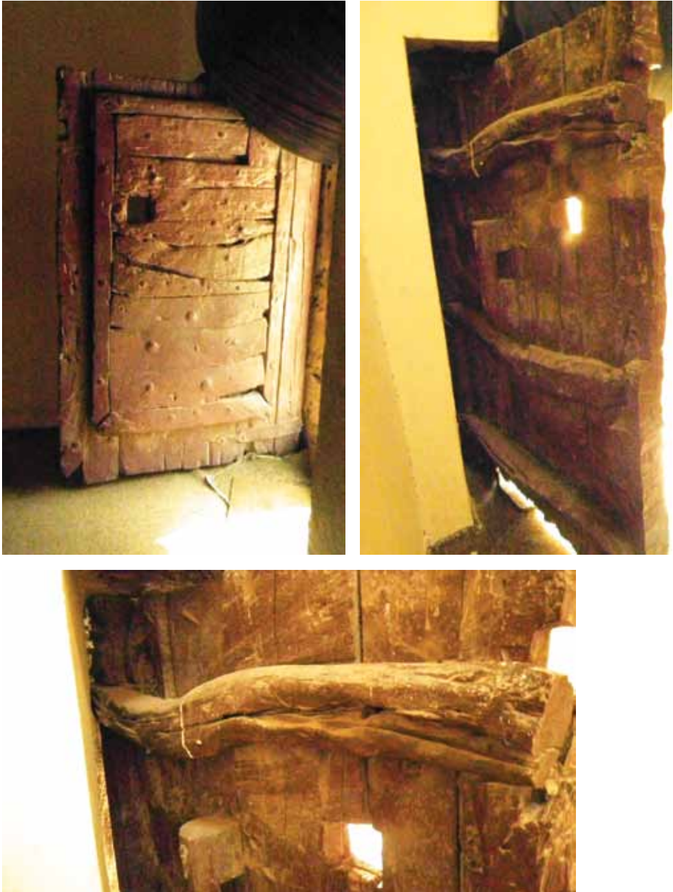
19. Egipt, Naclum-Fajum, klasztor koptyjski. Ciesielskie drzwi biegunowe o tafli deskowej z poziomymi listwami wykonanymi z gałęzi, zdwojonej z szeroką przylgą. Drewniane czopy osadzone w kamiennych gniazdach. Fot. w. Weker, maj 2013 r.
