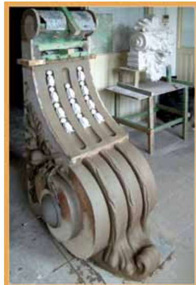
Modelowanie w 2012 r. woluty w celu zrekonstruowania szczytu północnego wejścia do Hali Mirowskiej
