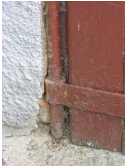
47. Kraków, Oleandry 4. Garaż przy schronisku młodzieżowym, proj. Edward Kreisler, 1931 r. Drzwi z żelaznymi biegunami, dwuskrzydłowe łamane, przylgowe. Fot. A. Cichy, 2013 r.
