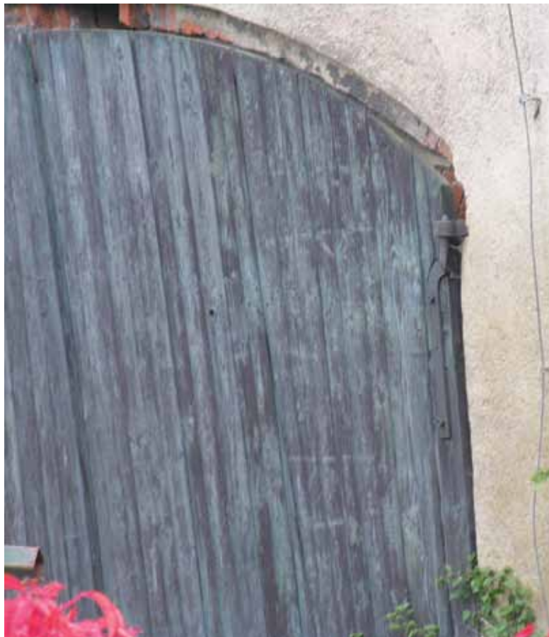
42. Wojsławice k / Niemczy. Budynek gospodarczy Arboretum Uniwersytetu Wrocławskiego. Dawny budynek folwarczny, 1883 r. Fragment skrzydła wrót biegunowych z żelaznym czopem i gniazdem. Fot. A. Cichy, 2013 r.
