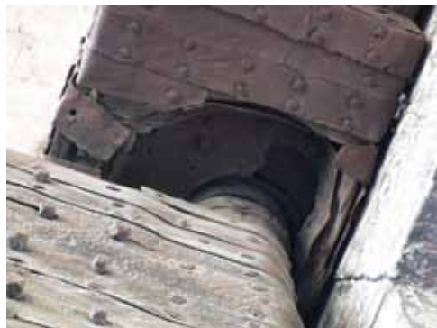
16. Egipt, Kair, Bab al-Futah, 1087 r. Przejazd bramy z widokiem dwuskrzydłowych wrót biegunowych o szerokości skrzydeł około 3 m. Zarówno drewniana tafla skrzydeł, jak i nadproże opierzone są kutymi żelaznymi blachami i płaskownikami przybitymi gwoździami o dużych główkach do drewnianego podkładu. Czopy i gniazda wzmacniano tą samą techniką. W ramach prac renowacyjnych wymieniono dolne partie opierzenia skrzydeł i odtworzono gniazdo i dolny czop, mocując go do stalowego spawanego ceownika nałożonego na naroże skrzydła. Fot. Władysław Weker, maj 2013 r.
