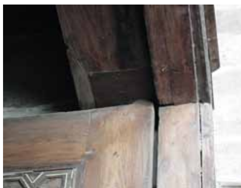
20. Kair. Meczet al-Muajjada (Czerwony Meczet), 1415-1421 r. Wejście do Mauzoleum al-Muajjada. Widok drzwi biegunowo ramowo-płycinowych oraz szczegóły dekoracji i połączenia górnego czopa ramiaka biegunowego z nadprożem. Do geometrycznej dekoracji awersu wykorzystano drewno inkrustowane kością i kamieniem. Czopy ramiaka biegunowego osadzone są w kamiennym progu i drewnianym nadprożu – wymiennym elemencie odrzwi. Fot. W. Weker, maj 2013 r.
