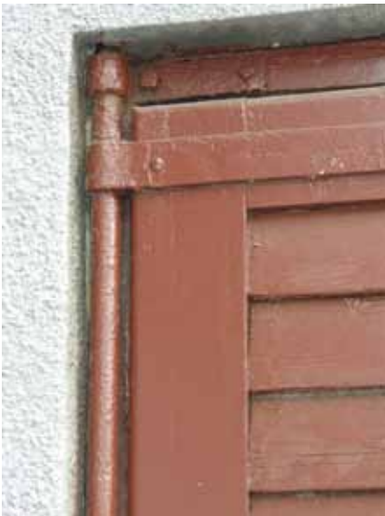
47. Kraków, Oleandry 4. Garaż przy schronisku młodzieżowym, proj. Edward Kreisler, 1931 r. Drzwi z żelaznymi biegunami, dwuskrzydłowe łamane, przylgowe. Fot. A. Cichy, 2013 r.
