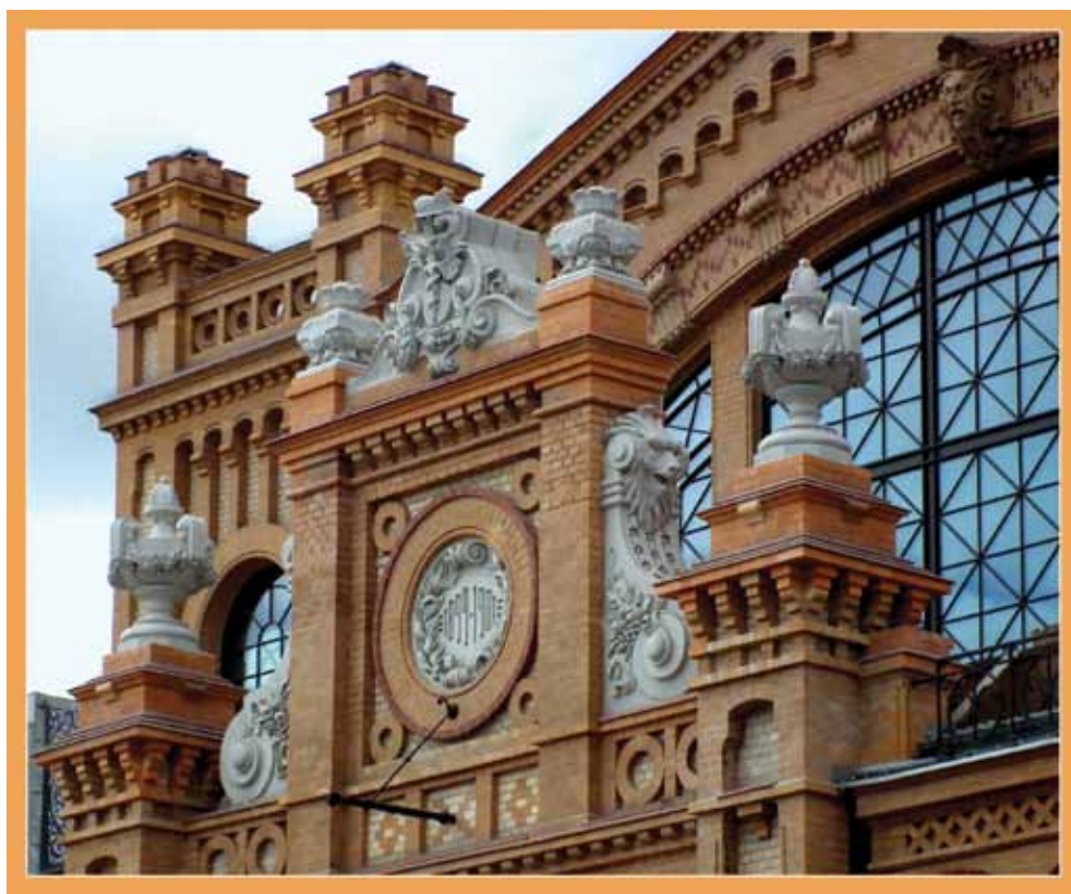
Poddany gruntownym pracom konserwatorskim szczyt nad wschodnim wejściem do Hali Mirowskiej
