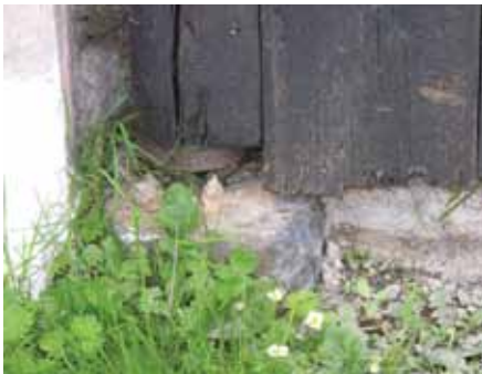
41. Gilów k/ Dzierżoniowa. Drewniane wrota biegunowe do stodoły (k. XIX w. (?)). Drewniane czopy obracają się w żelaznych obejmach wmurowanych w ścianę, czop dolny z dodatkowym podparciem na kamiennej podkładce. Fot. A. Cichy, 2013 r.
