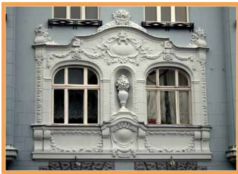
Bogate barokowe sztukatorskie zdobienie dwóch okien na fasadzie kamienicy przy ulicy Mokotowskiej
