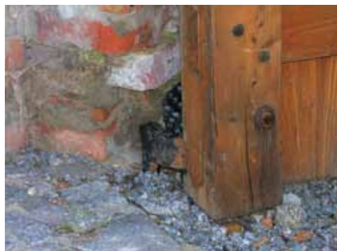
43. Wojsławice k/ Niemczy. Współczesne wrota biegunowe z żelaznymi czopami odtworzone w ramach adaptacji dawnego budynku folwarcznego na salę ekspozycyjną Arboretum Uniwersytetu Wrocławskiego. W skrzydłach zewnętrznych powtórzono rozwiązania konstrukcyjne tafli wykorzystując zachowane częściowo żelazne okucia zachowane w węgarach i odzyskane ze zniszczonych skrzydeł. Fot. A. Cichy, 2013 r.
