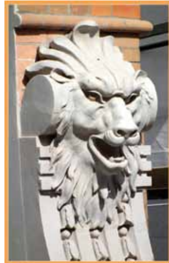
Odtworzona w 2012 r. w zaprawie renowacyjnej woluta na szczycie nad północnym wejściem do Hali Mirowskiej
