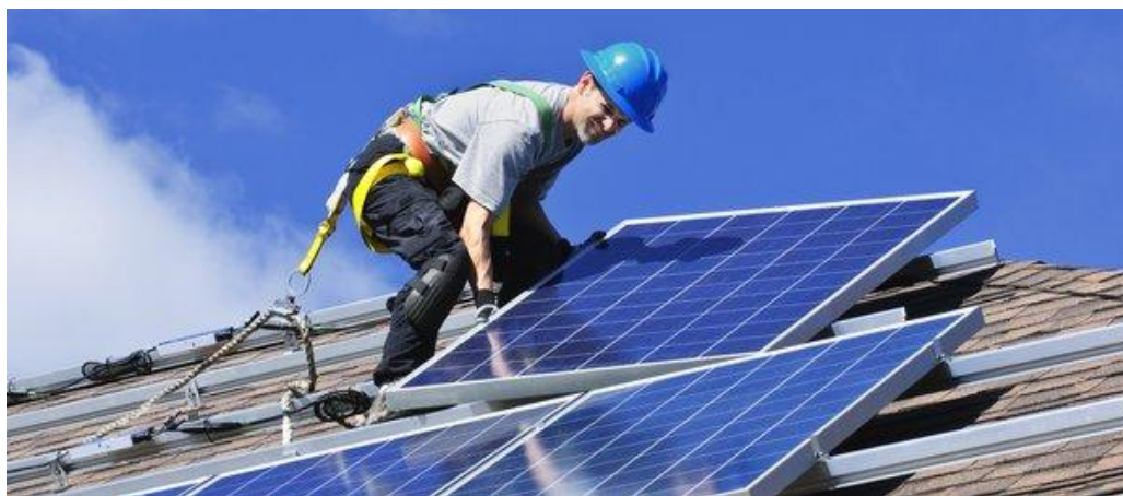
Montaż paneli słonecznych na dachu domu mieszkalnego [fot. Shutterstock]
