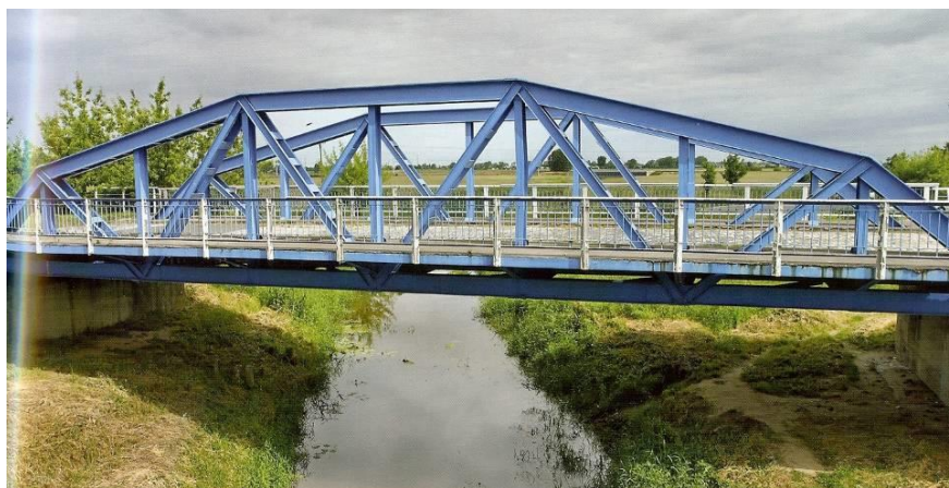
Rysunek 46. Pierwszy na świecie spawany most drogowy na Słudwi koło Łowicza. Konstrukcja inżyniera Stefana Bryły.
