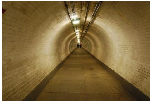
Tunel pod Tamizą
