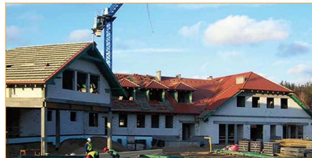
Budowa hotelu w Worytach koło Gietrzwałdu
