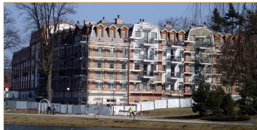
Budowa Rezydencji „STARY SPICHLERZ” w Łławie. Między innymi właśnie na tej budowie realizowany był projekt „Lider Kształcenia Zawodowego”
