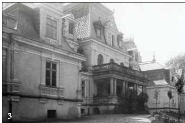
3. Elewacja frontowa, stan z lat 20. XX w.
